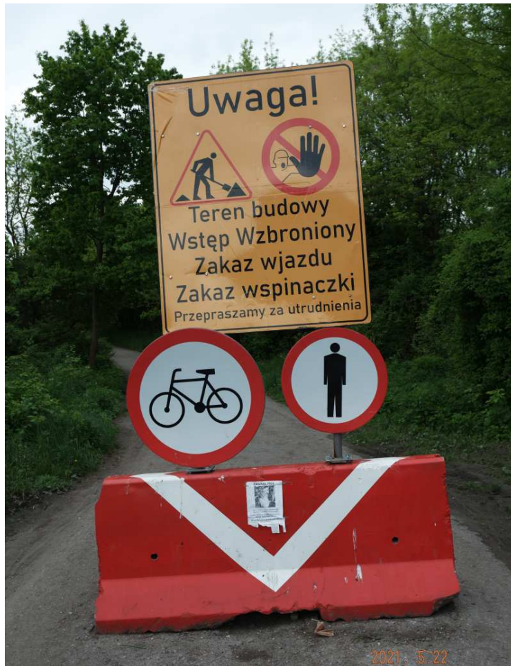
Fot. nr 4. Zbiornik na Zakrzówku na etapie rewitalizacji.
