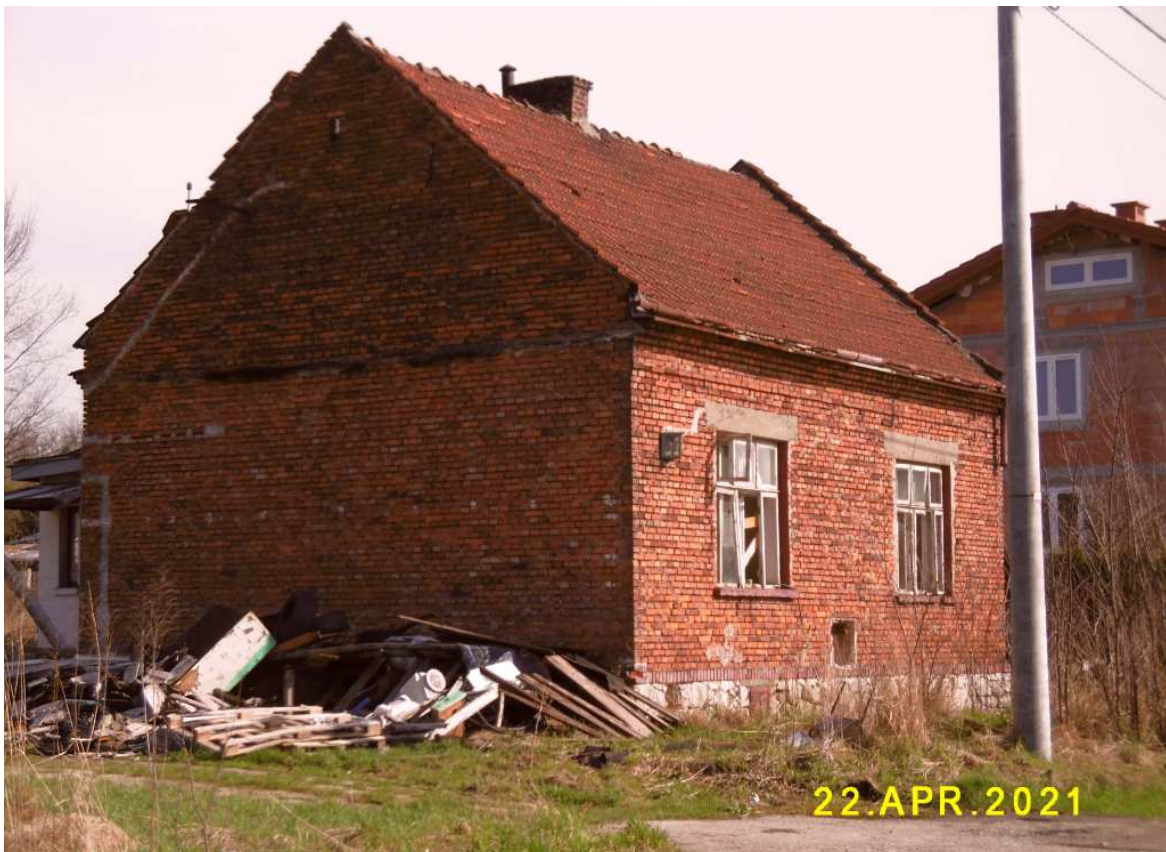
Fot. nr 409 (409-410). Dom z cegły z ulicy Myślenickiej 52, raczej już powojenny, w którym zachowały się jeszcze trzyczęściowe okna, otwierane na zewnątrz, charakterystyczne dla tego okresu.
