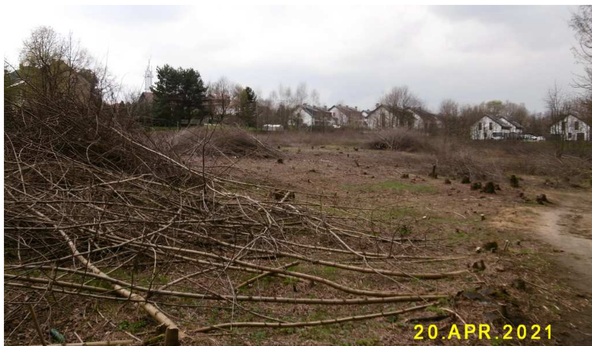
Fot. nr 332. Splantowane już tereny pod zabudowę w sąsiedztwie ulic: Rząckiej i Obronnej.
