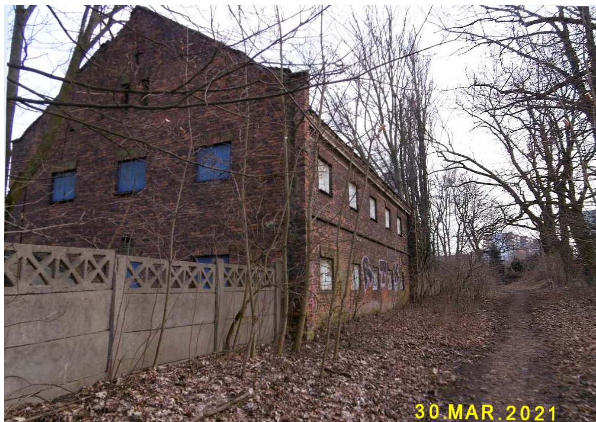
Fot. nr 242. Końcowy fragment ulicy Żniwnej przy jej wylocie do alei Dygasińskiego.
