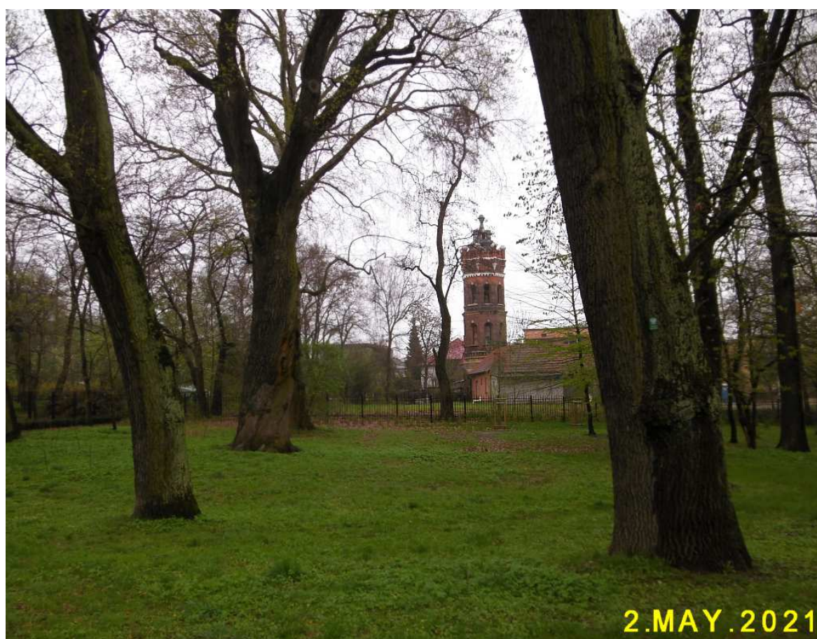
Fot. nr 271 (271-272). Dawna wieża ciśnię przy ulicy Górników 25.
