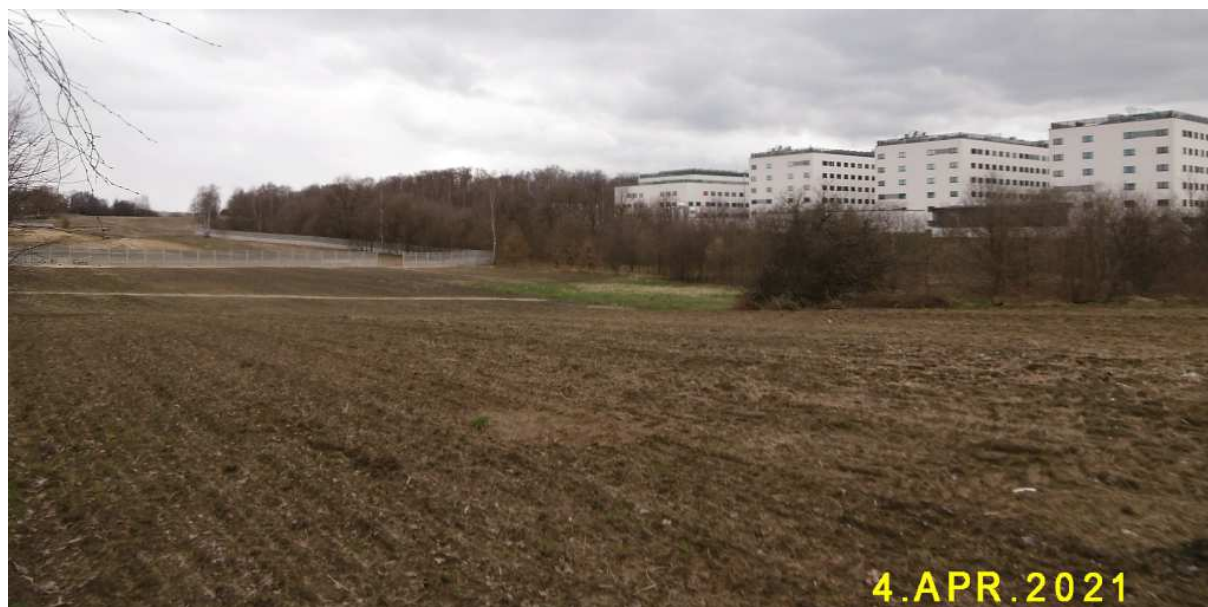
Fot. nr 301 (301-309). Paskudnie wygradzony przez przyszłego, ewentualnego dewelopera teren wzdłuż ulicy Słona Woda. To taka „mała” samowola budowlana, bo los utworzenia tu użytku ekologicznego nie jest jeszcze przesądzony. Widoki od strony osiedla Rżaka.
