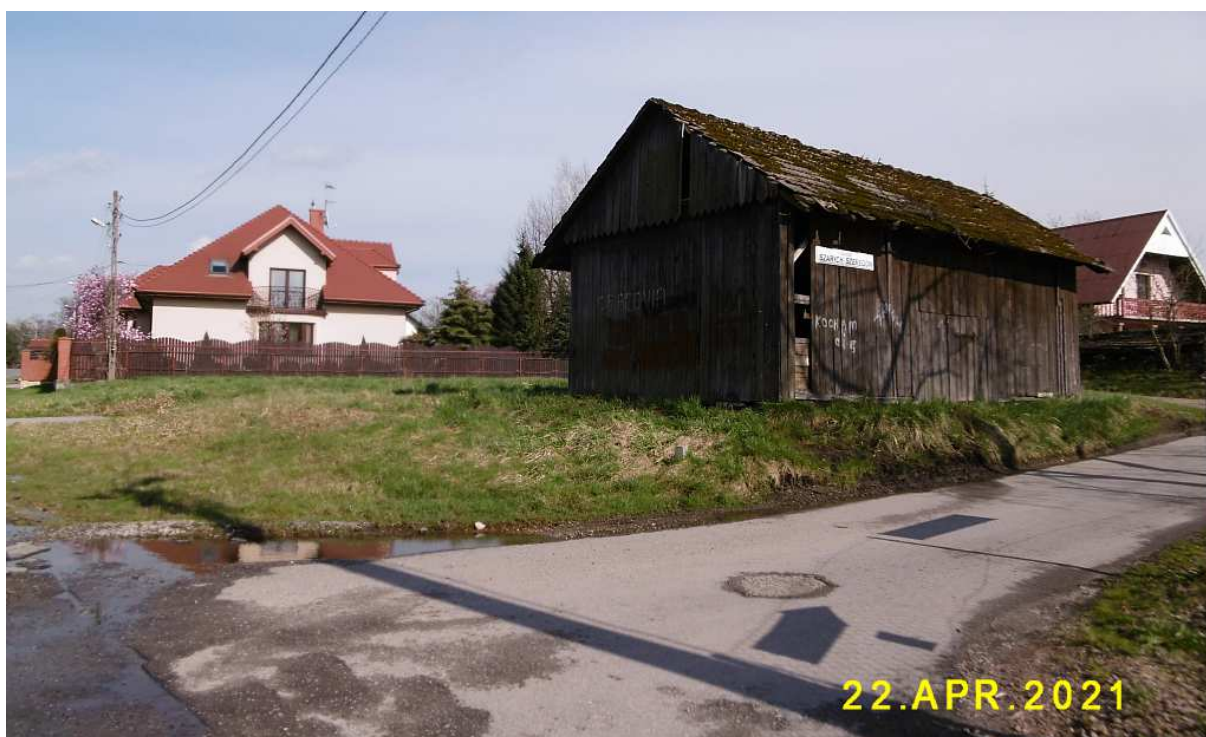
Fot. nr 411 (411-413). Stodoła na posesji przy ulicy Łężce 8 (?), róg z ulicą Szarych Szeregów.
