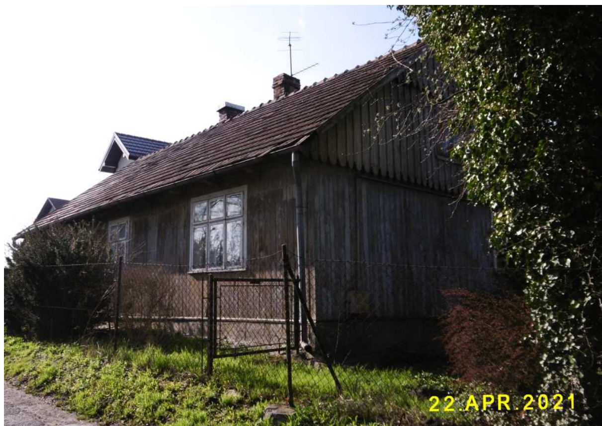
Fot. nr 384. Fasada od strony ulicy Łężce.
