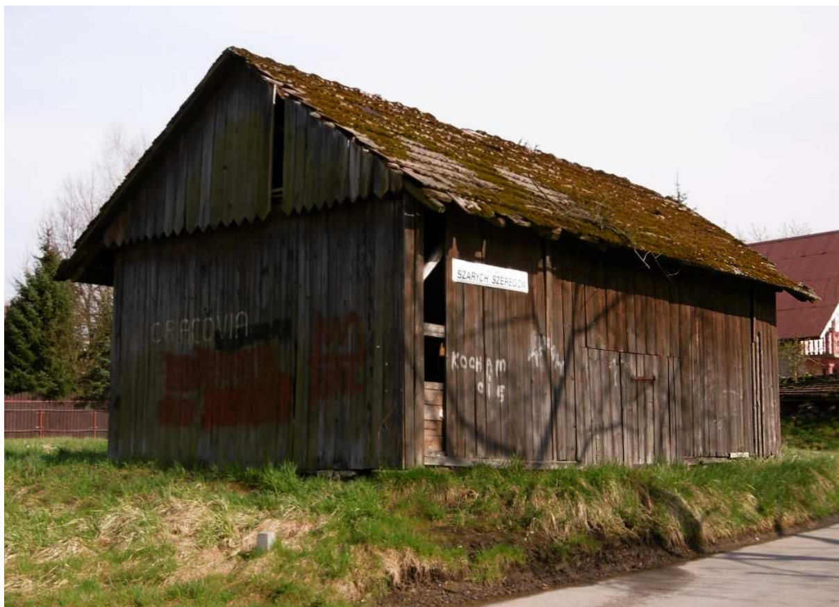
Fot. nr 412. Ujęcie od strony ulicy Szarych Szeregów.
