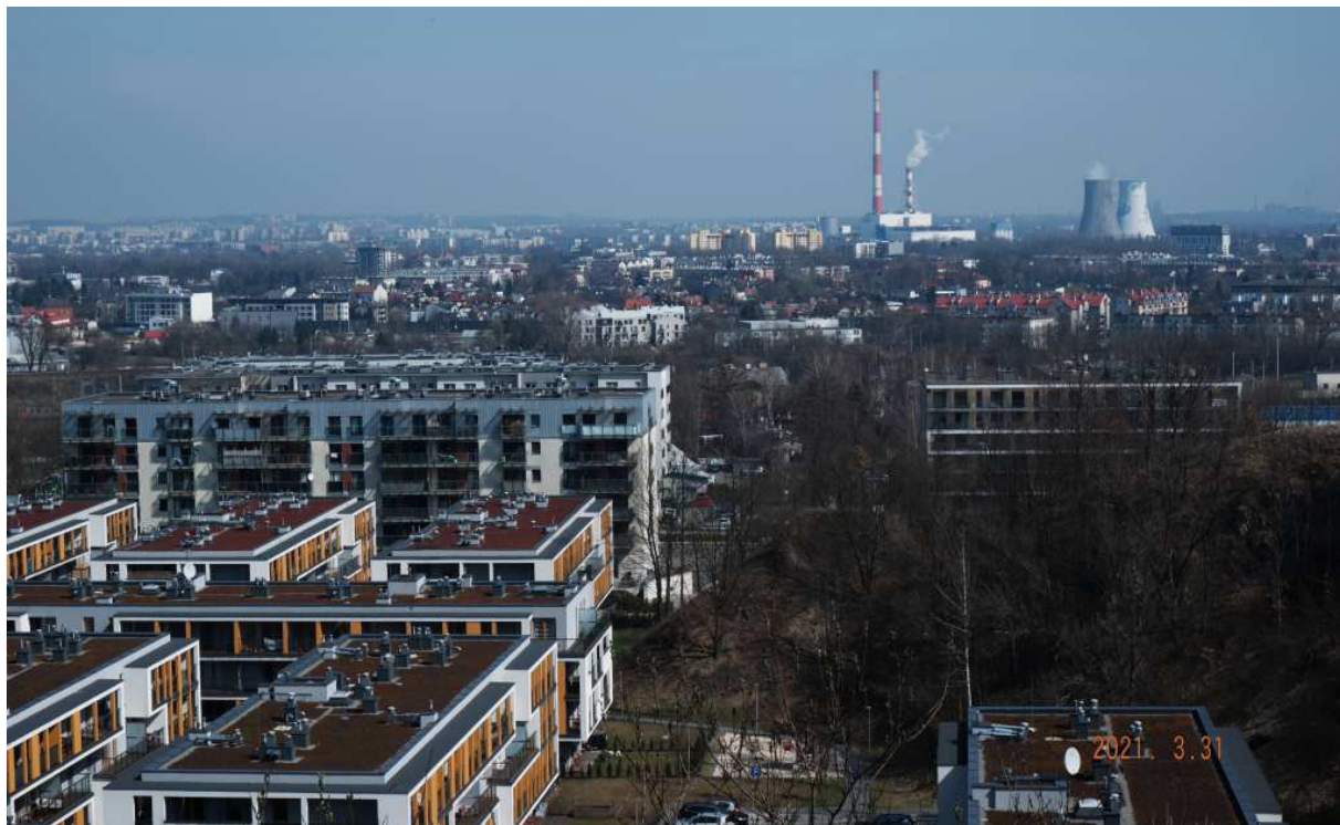
Fot. nr 41 (41-42). Współczesne widoki na „osiedle koncentracyjne” przy ul. Wielickiej 57.
