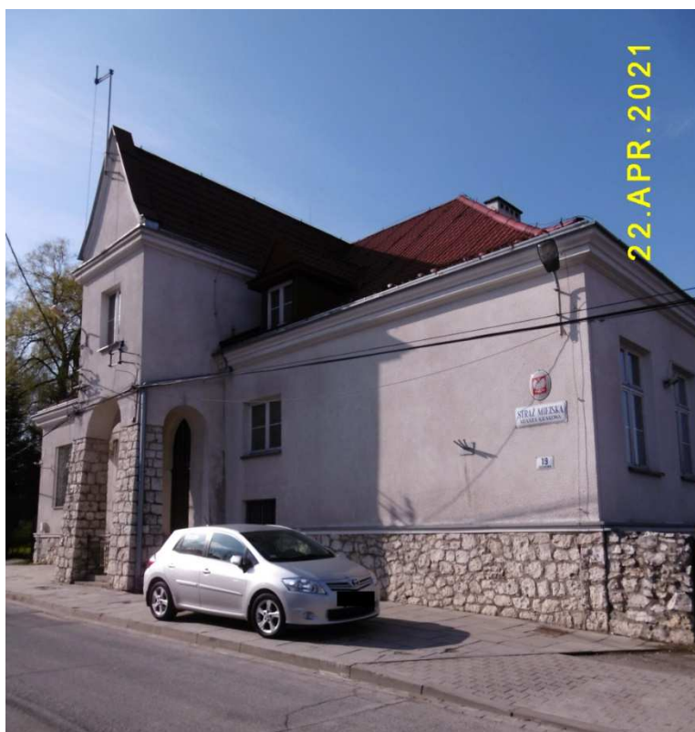
Fot. nr 381. Widok na fasadę.
