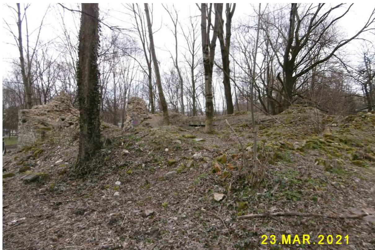
Fot. nr 145 (145-146). Ruina dawnych zabudowań gospodarczych dworu we fragmencie od strony ulicy Albańskiej.
