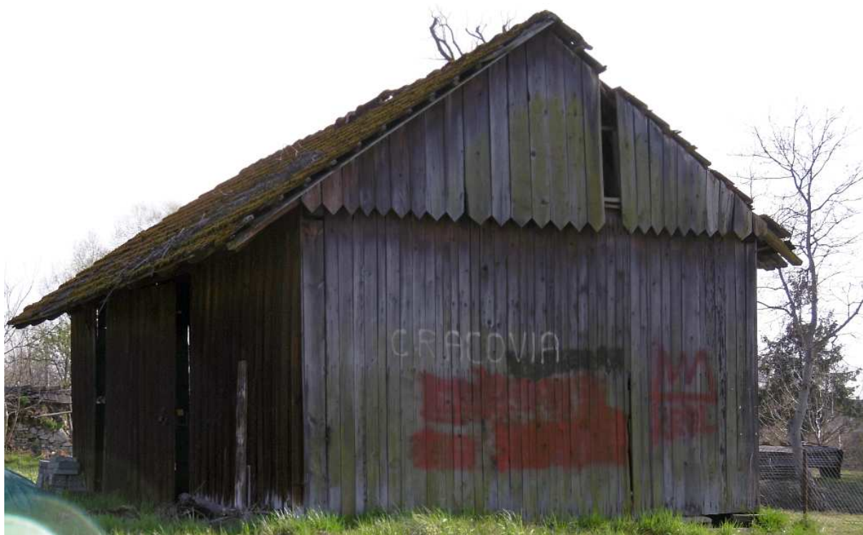
Fot. nr 413. Fragment od strony podwórka.
