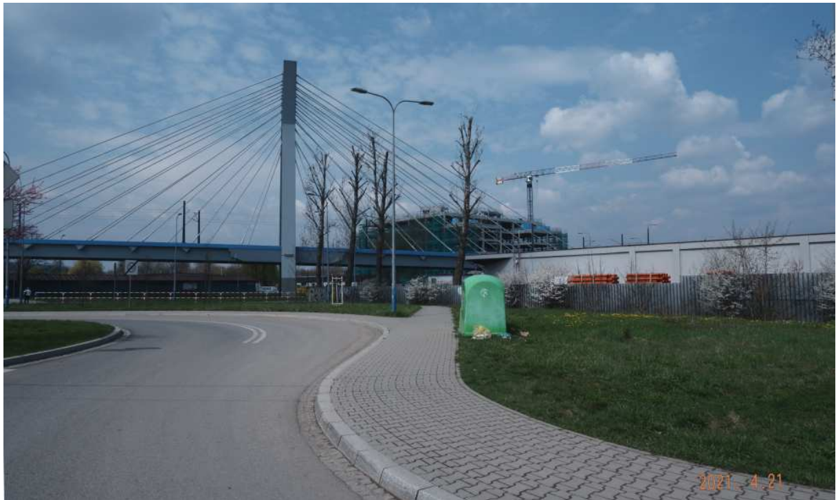
Fot. nr 208 (208-210). Szybko rozrasta się nowa zabudowa w rejonie ulic: Żołnierskiej, Saskiej i Kuklińskiego.
