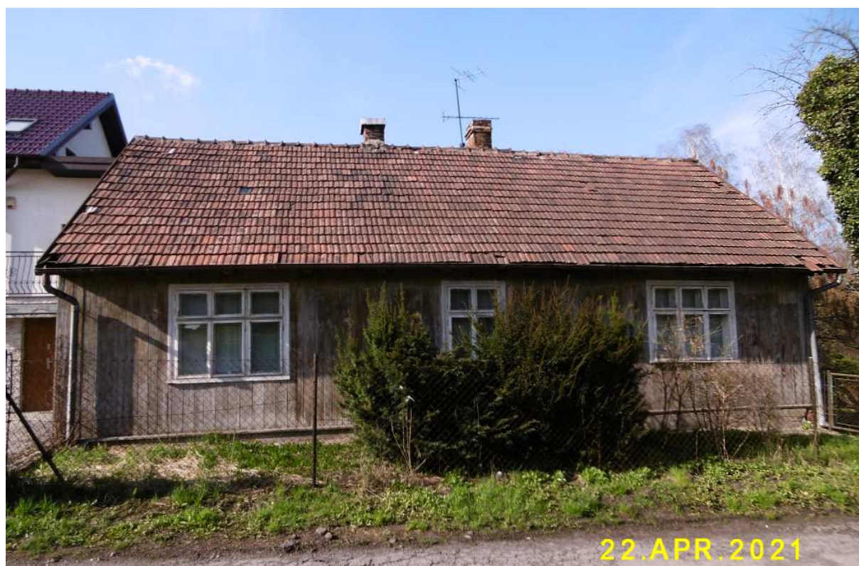
Fot. nr 383 (383-387). Zabudowa posesji z ulicy Cechowej 28. Tu około 90-letni dom.
