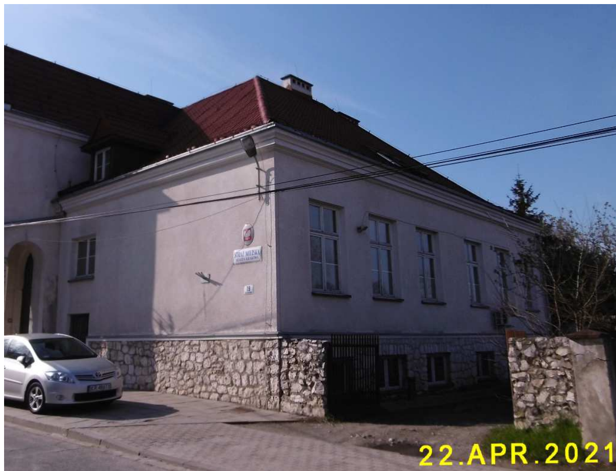
Fot. nr 382. Boczny fragment budynku.
