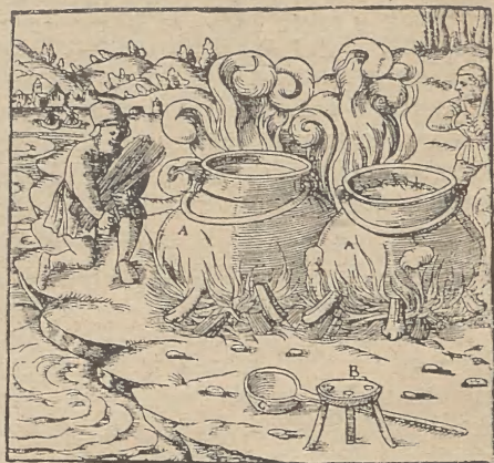
Rys. 16. Otrzymywanie soli kuchennej przez odparowywanie wody morskiej w dużych żelaznych garnkach.
