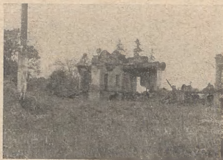
Rys. 3. Cha-Pa. Coline de la résidence supérieure. W tym miejscu po rozbiorze ruin zainstalowany będzie radioteodolit aerologiczny
