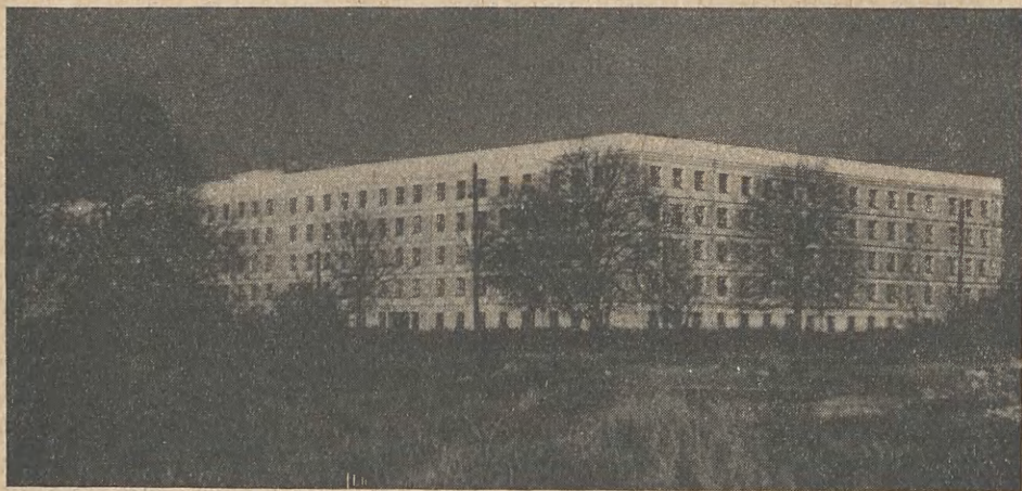
Rys. 1. Gmach Wydziału Geologii UW przy ulicy Żwirki i Wigury 6
