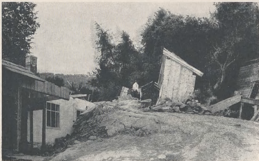
Rys. 5. Zniszczone zabudowania gospodarskie w Wapiennej koło Muszyny
