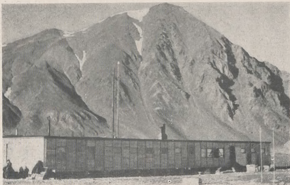
Dom stacji polskiej w Hornsundzie zbudowany przez uczestników wyprawy w r. 1957 z prefabrykatów przywiezionych z kraju
