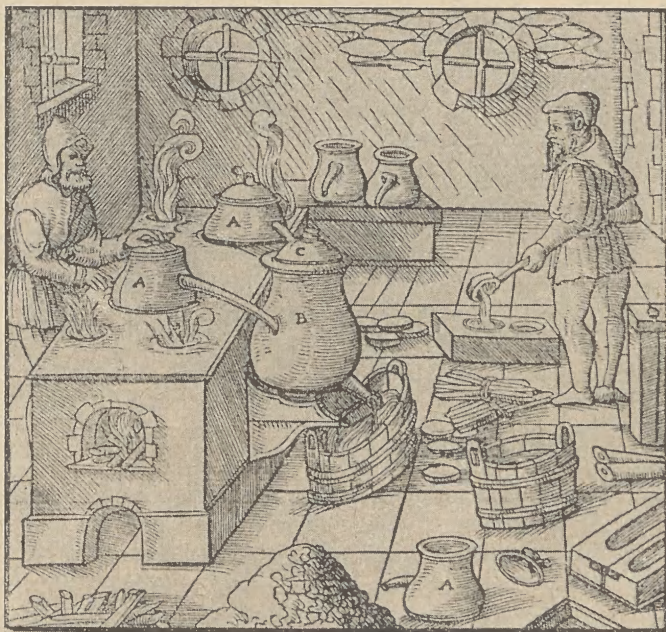
Rys. 5. Laboratoryjne otrzymywanie siarki w XVI wieku wg Agricoli De Re Metallica , Bazylea 1556
