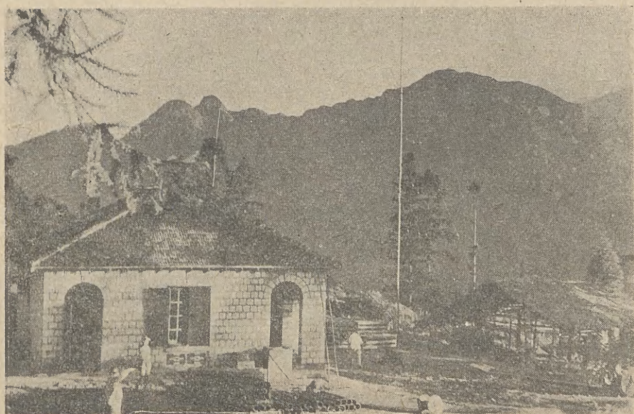
Rys. 2. Cha-pa. Budynek radiostacji i pracowni naukowej.
