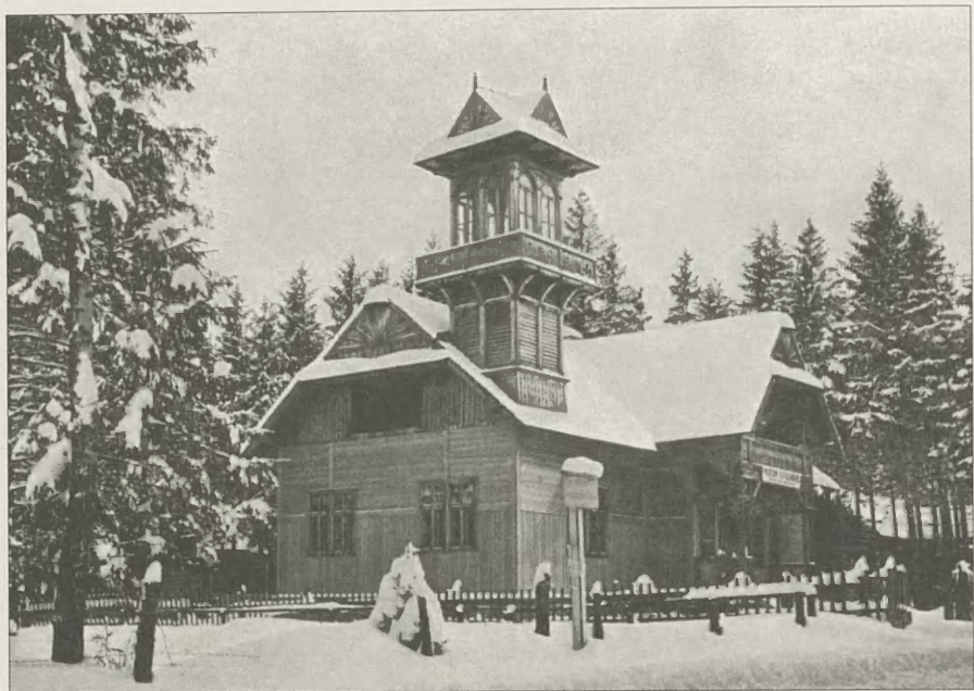
Drewniany budynek Muzeum Tatrzańskiego przy ul. Tytusa Chałubińskiego
