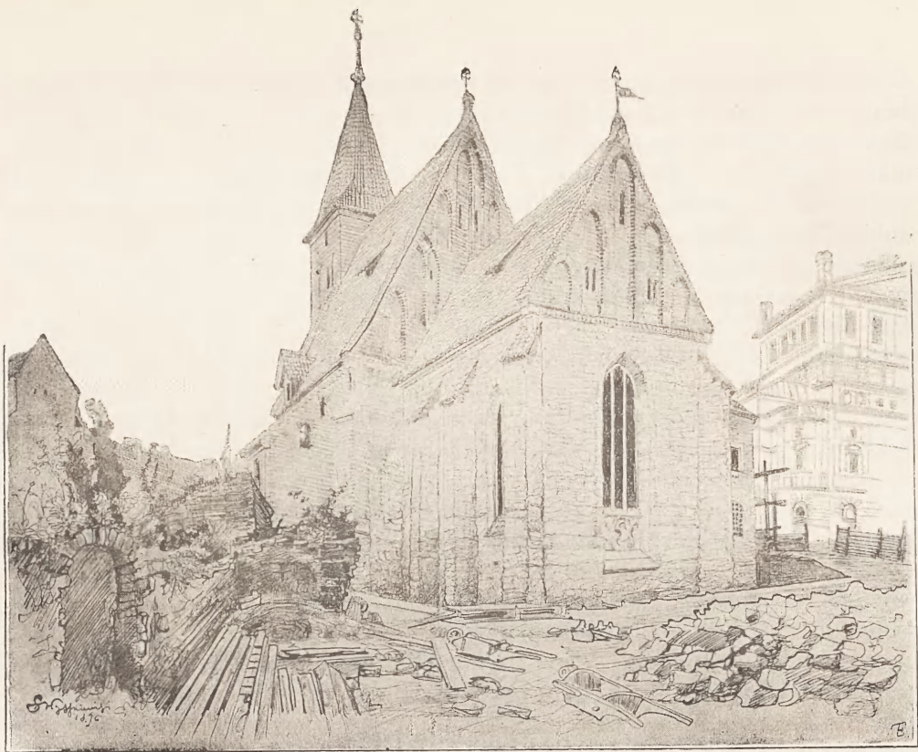
Fig. 1. Widok zewnętrzny kościoła św. Krzyża podczas restauracji.
