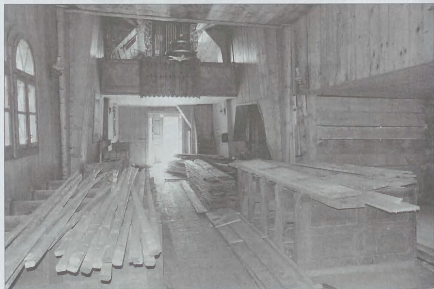
Adaptacja wnętrza nawy głównej będzie następnym etapem renowacji
