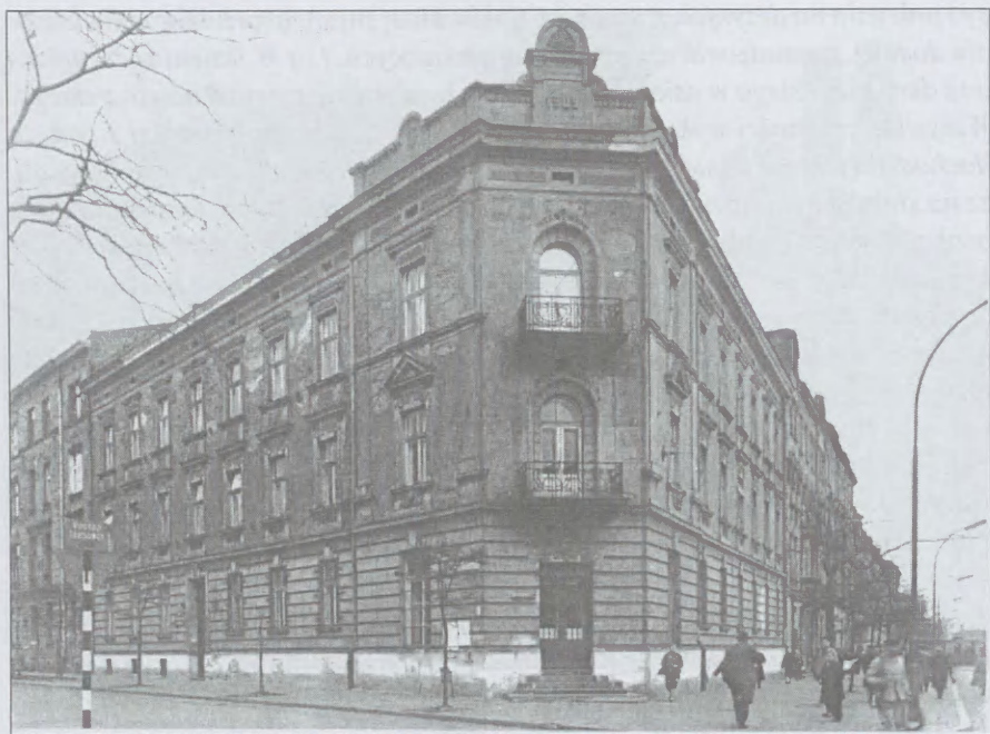
Siedziba Wojewódzkiej Stacji Sanitarno-Epidemiologicznej w Krakowie
