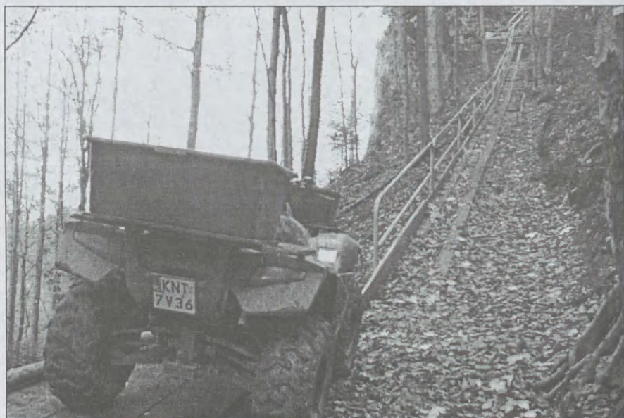
Elektryczna wciągarka i kłady pomagają w transporcie materiałów
