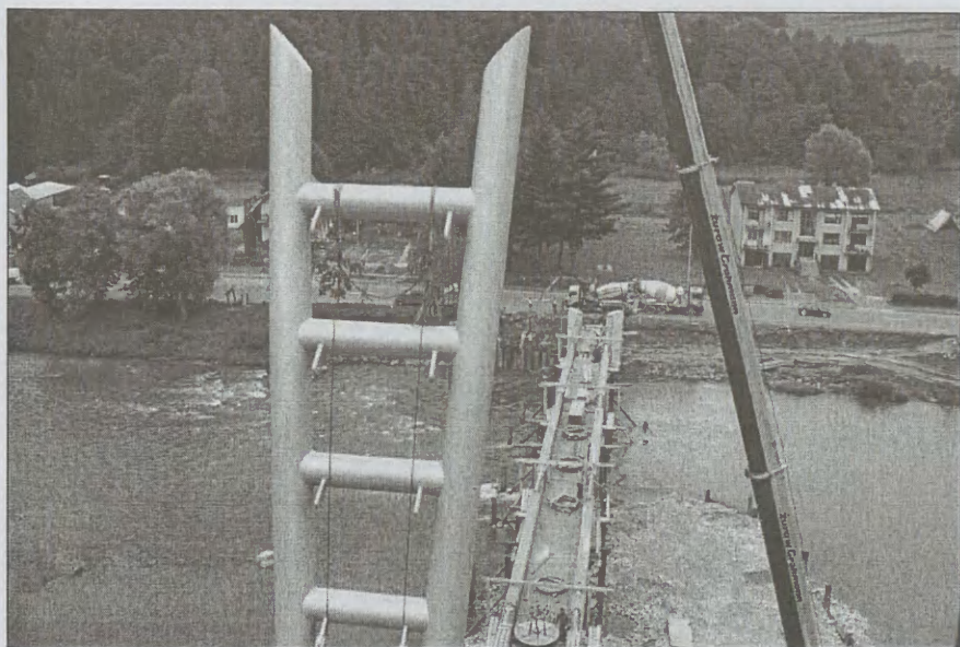
Kładka w budowie, widok z wysokości pylonu, wykonane z kosza na wyciągniku dźwigowym
