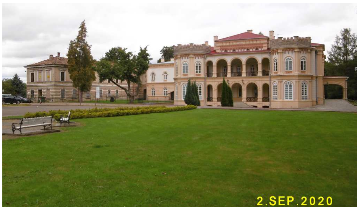
Fot. nr 168 (168-169). Widoki na zespół pałacowy od południa (od strony dawnego ogrodu).
