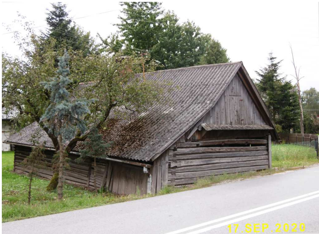
Fot. nr 225 (225-233). Archaiczna chałupa przy ulicy Budziwojskiej pod nr 357, która mogła zostać wybudowana nawet w połowie XIX wieku. Tu jej tylna część.
