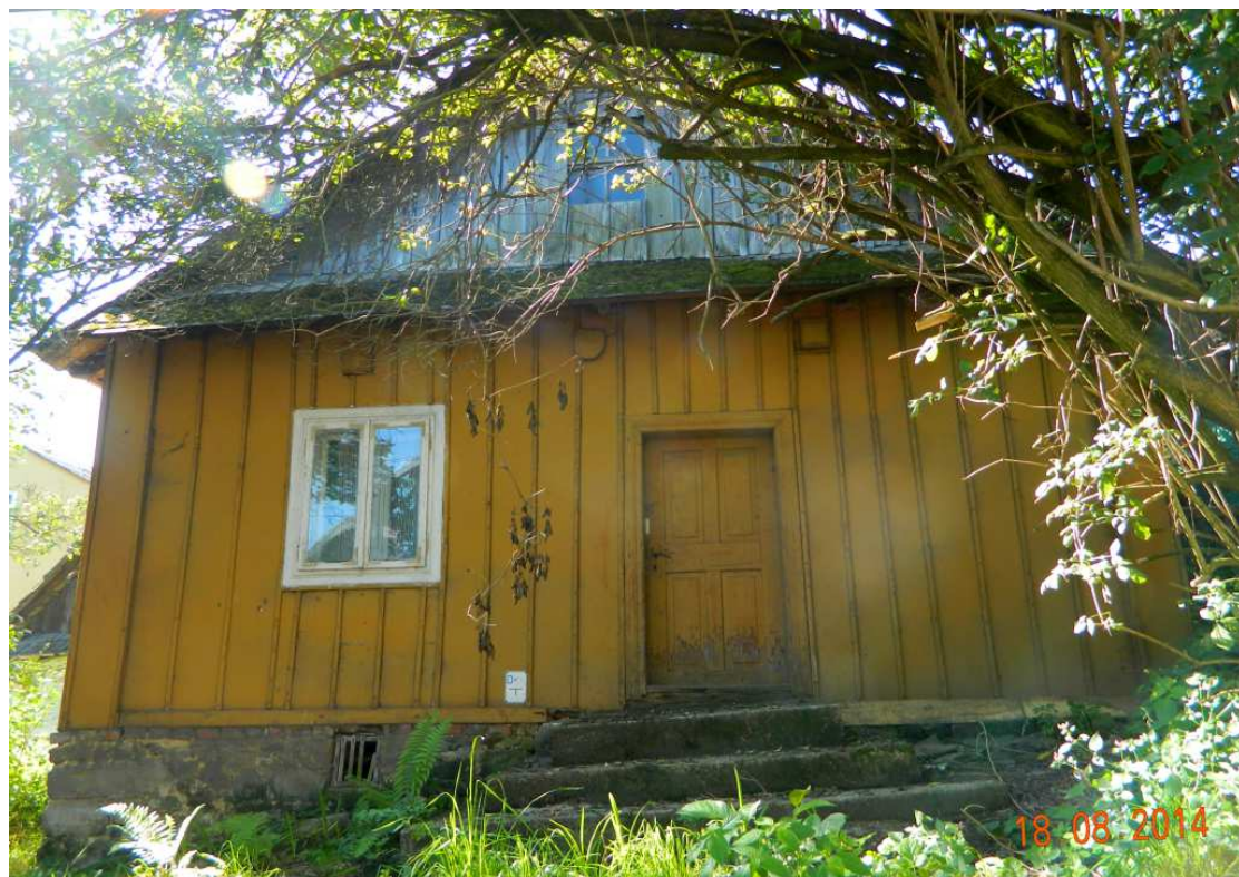
Fot. nr 64 (64-65). Ściana szczytowa zapewne drewnianego, obitego szalunkiem z listwami domu z ulicy św. Katarzyny 2, który mógł powstać ok. roku 1925.
