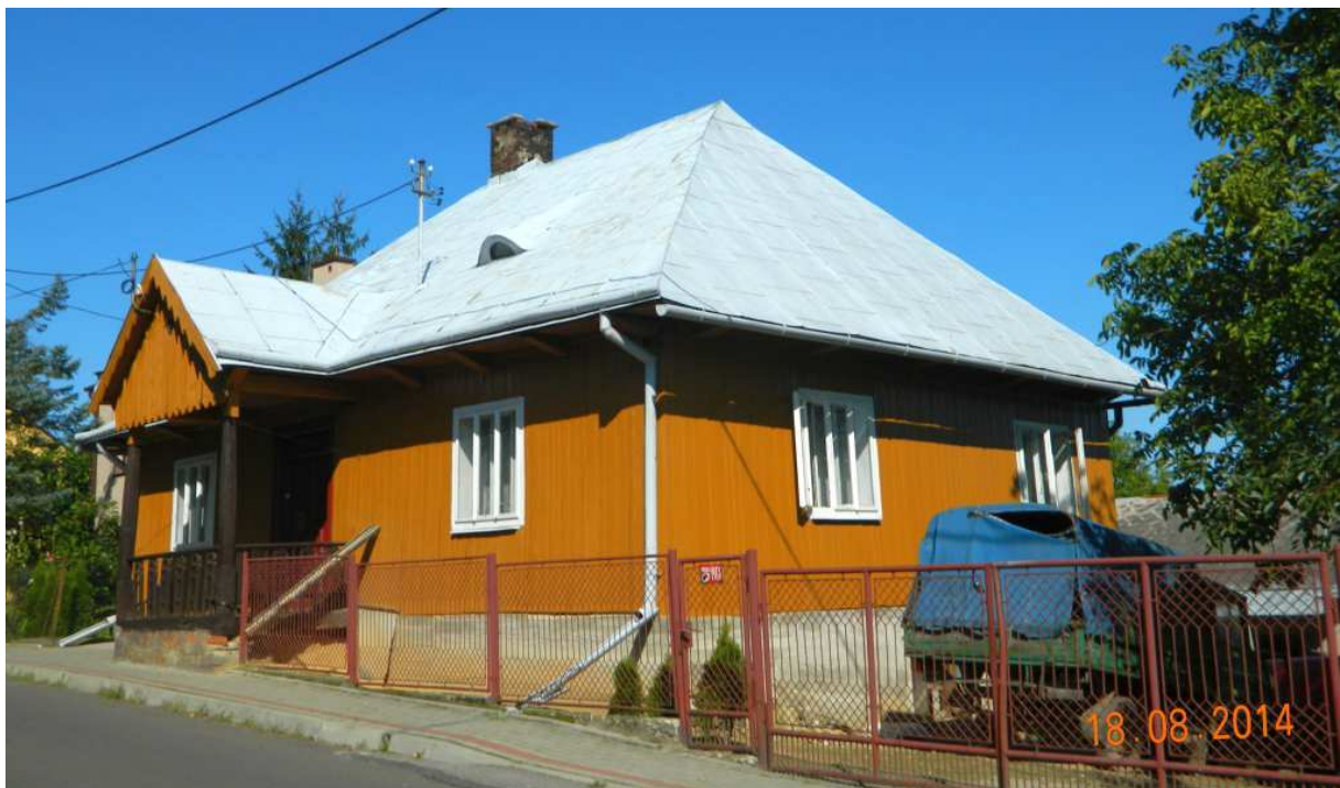
Fot. nr 100 (100-103). Dom przy ulicy św. Krzyża 19 o wyglądzie skromnego dworku, z gankiem w kształcie portyku, który mógł powstać pod koniec XIX wieku.
