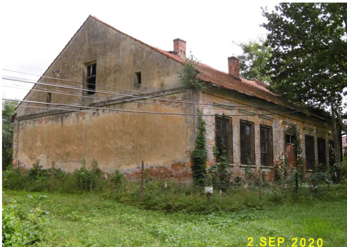
Fot. nr 217 (217-221). Ruina dawnej szkoły w narożu ulic: Podleśnej i Sportowców. Budynek powstał pod koniec XIX wieku. Fot. nr: 217-219 – fasada od strony ulicy Podleśnej.
