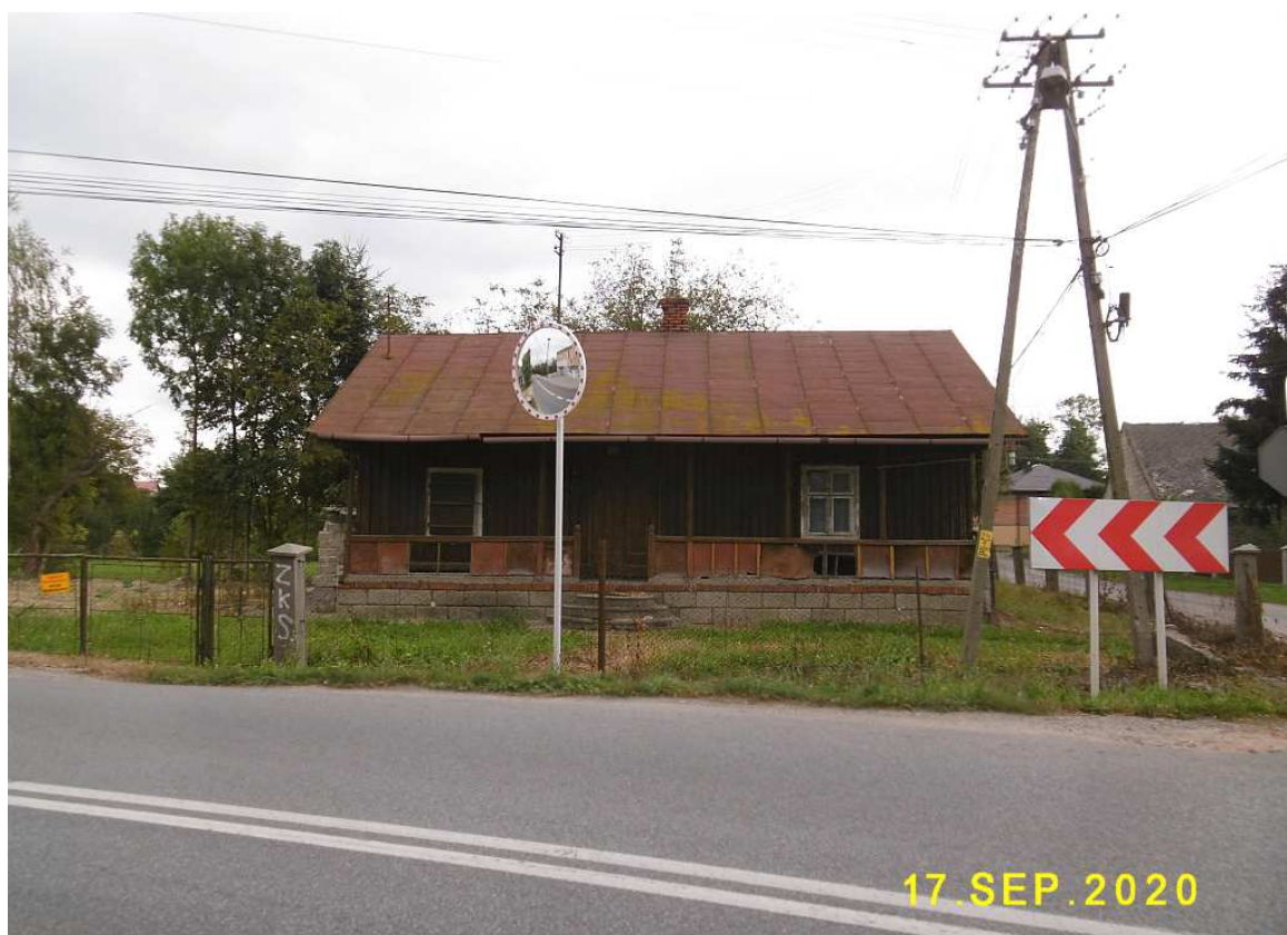
Fot. nr 235 (235-238). Fasada obiektu od strony drogi.
