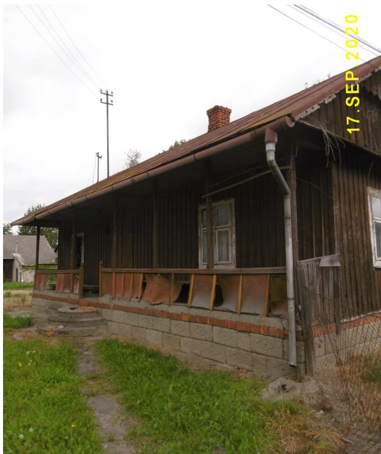
Fot. nr 239 (239-240). Okapowy dach nad odsłoniętą werandą.
