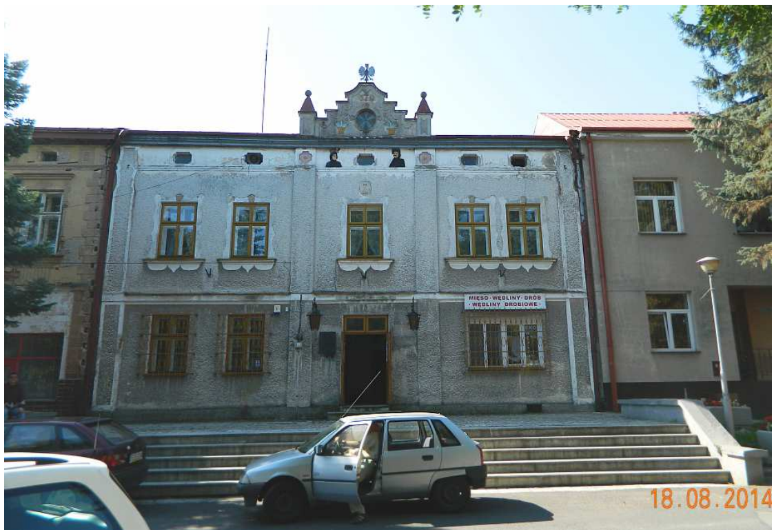
Fot. nr 19 (19-30). Zabudowa południowej pierzei Rynku. Fot. nr: 19-23 - urokliwa kamieniczka z Rynku 24, przebudowana w roku 1921.
