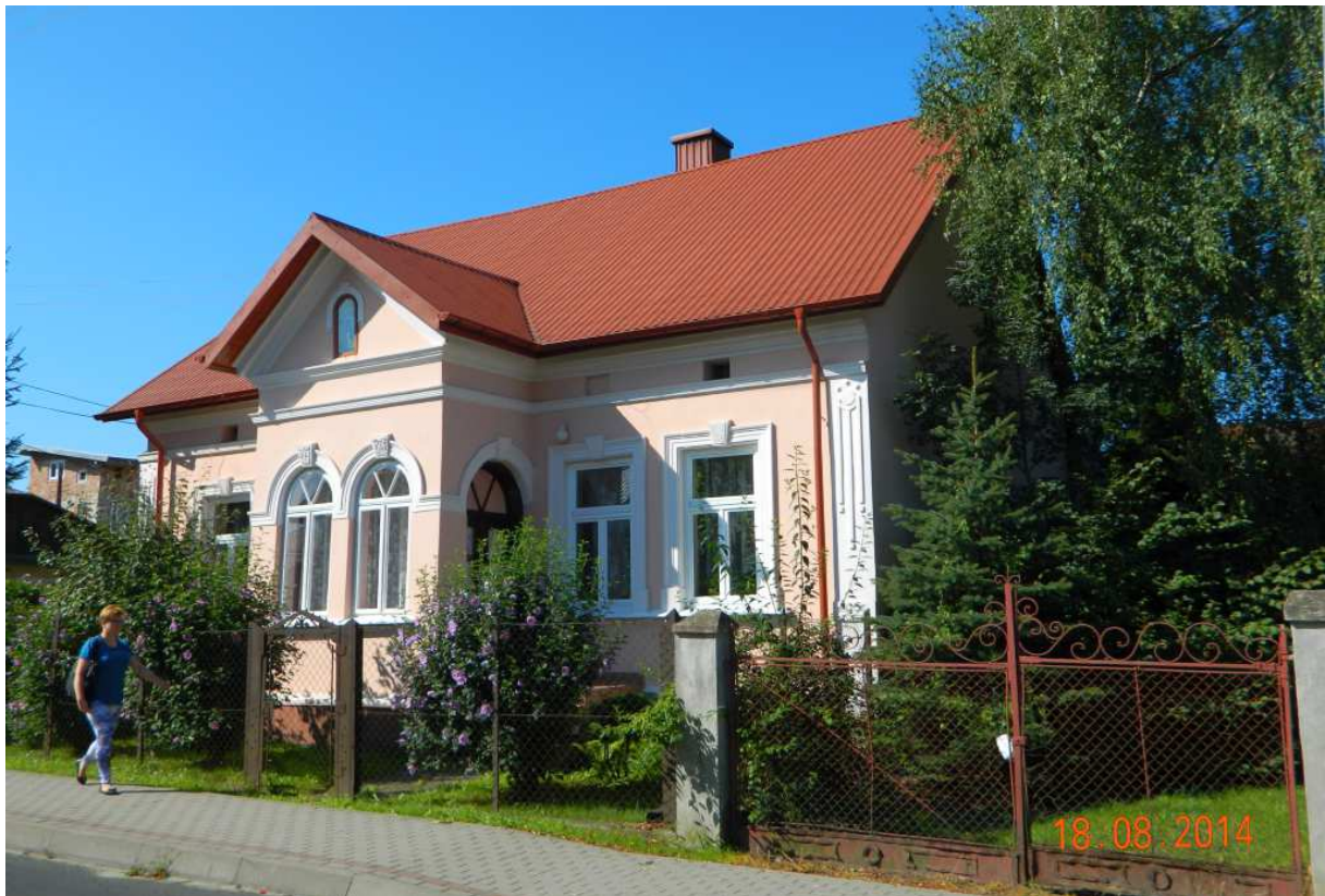
Fot. nr 53 (53-53a). Zapewne niespełna 100-letni murowany dom z gankiem spod nr 28.
