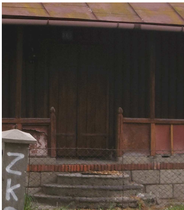
Fot. nr 238. Drzwi i detale balustrady werandy.
