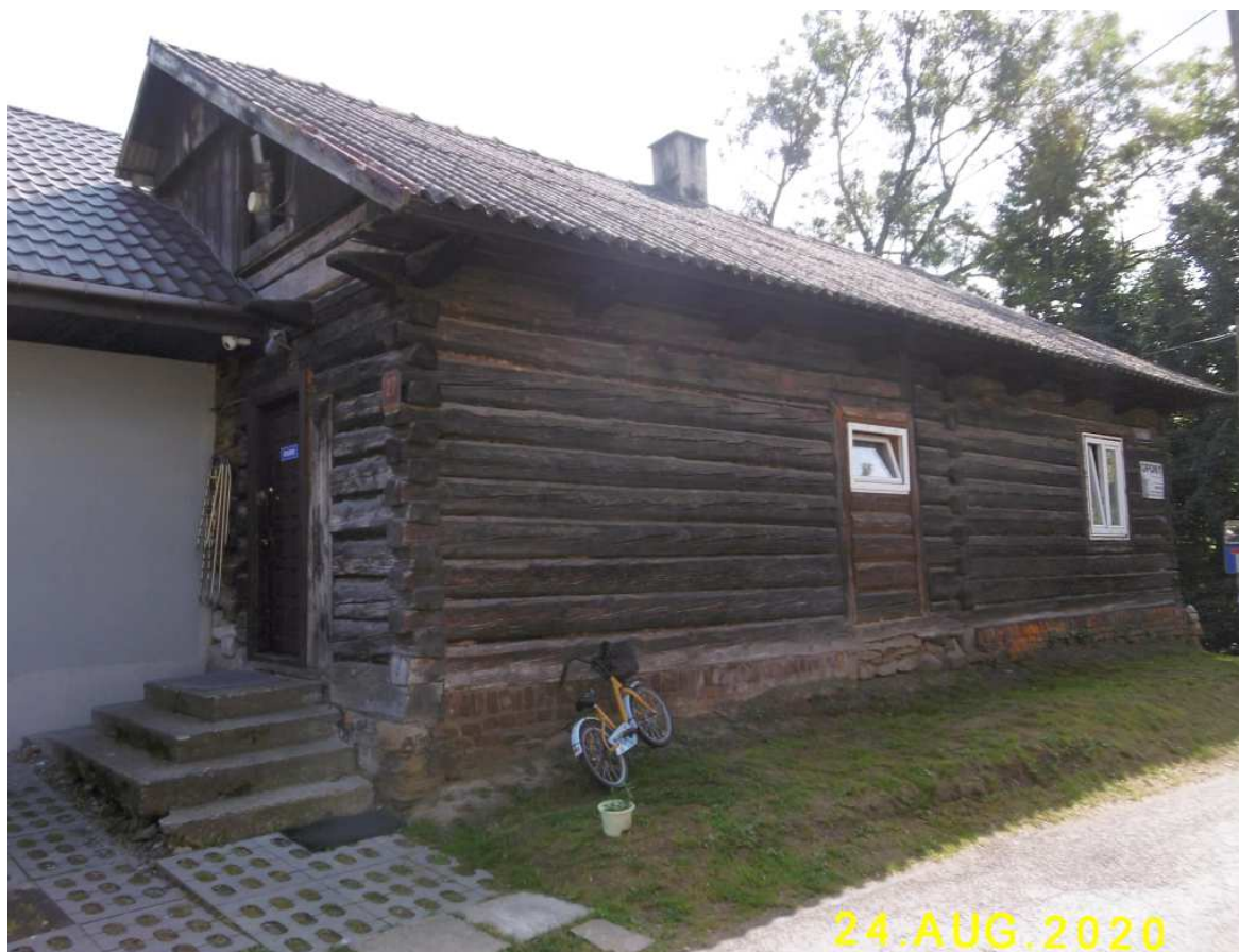
Fot. nr 69. Widok z ulicy Podwale.
