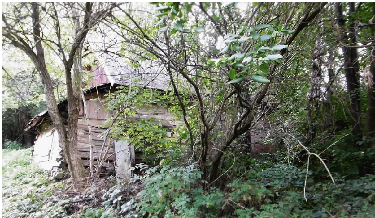
Fot. nr 105. Widok na tylną część chałupy.
