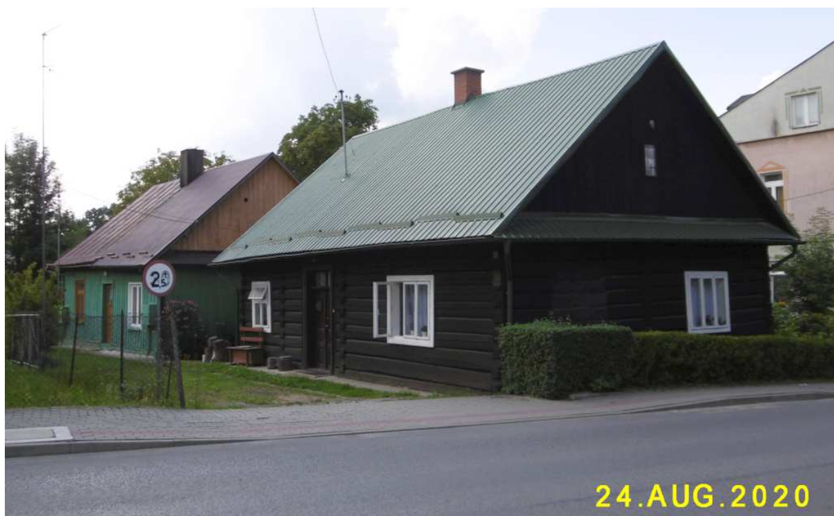
Fot. nr 134 (134-135). Chałupy wybudowane już zapewne po I wojnie światowej spod nr: 11 i 13.
