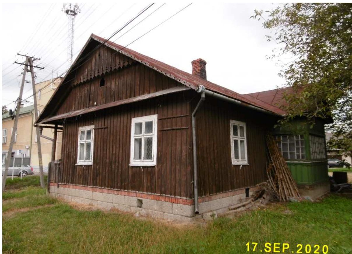
Fot. nr 241 (241-242). Tylna część z zaszklonym gankiem.
