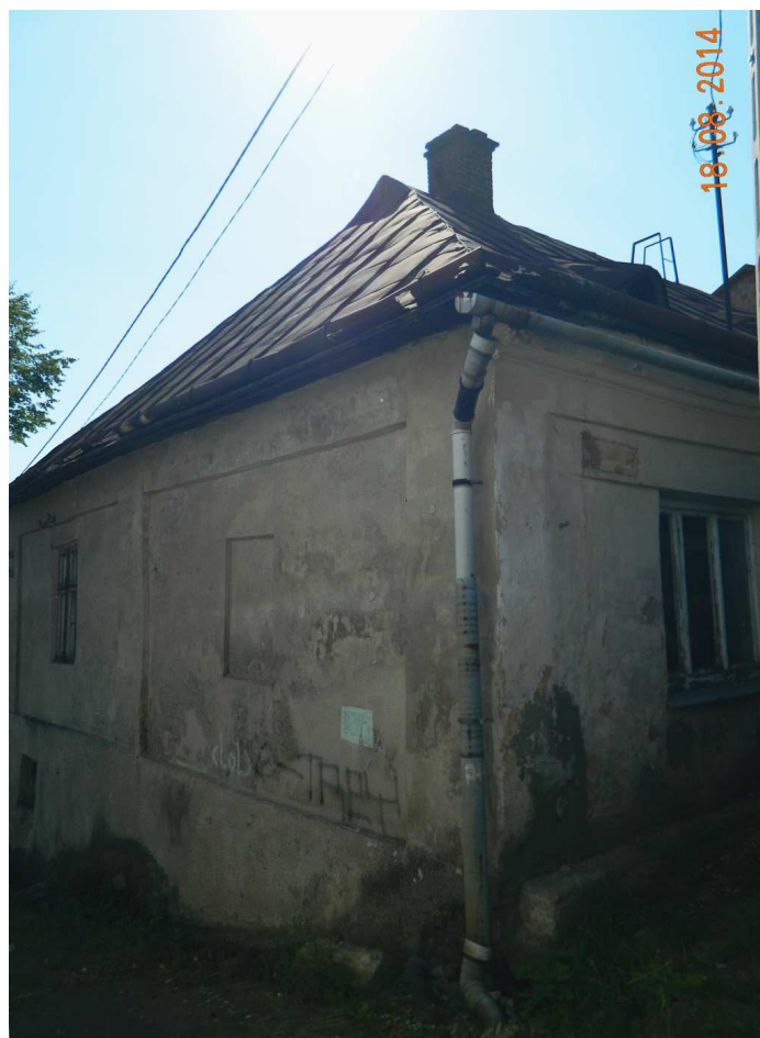
Fot. nr 80. Spojrzenie przez ogrodzenie na narożnik domu.
