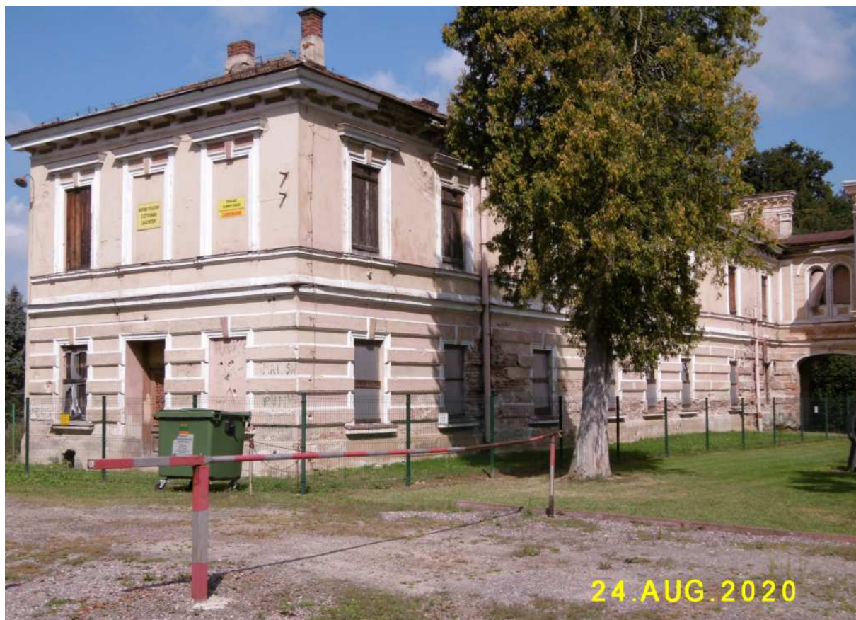
Fot. nr 179 (179-180). Oficyna w oczekiwaniu na renowację.
