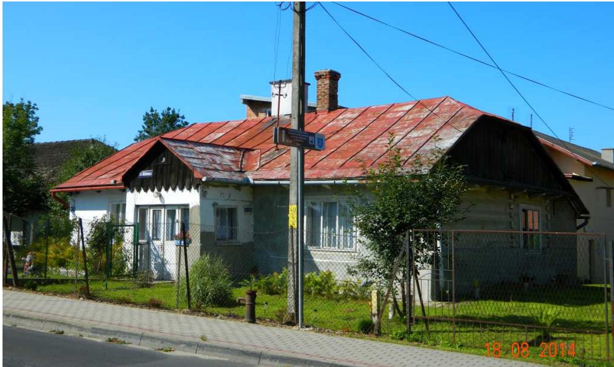
Fot. nr 54 (54-54a). Zniekształcona już fasada dwutraktowej chałupa o konstrukcji zrębowej i przemurowanym ganku spod nr 30. Mogła powstać w I ćwierci XX wieku.
