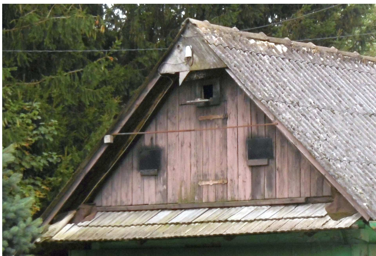
Fot. nr 212. Gołębiki w zwieńczeniu ściany szczytowej.
