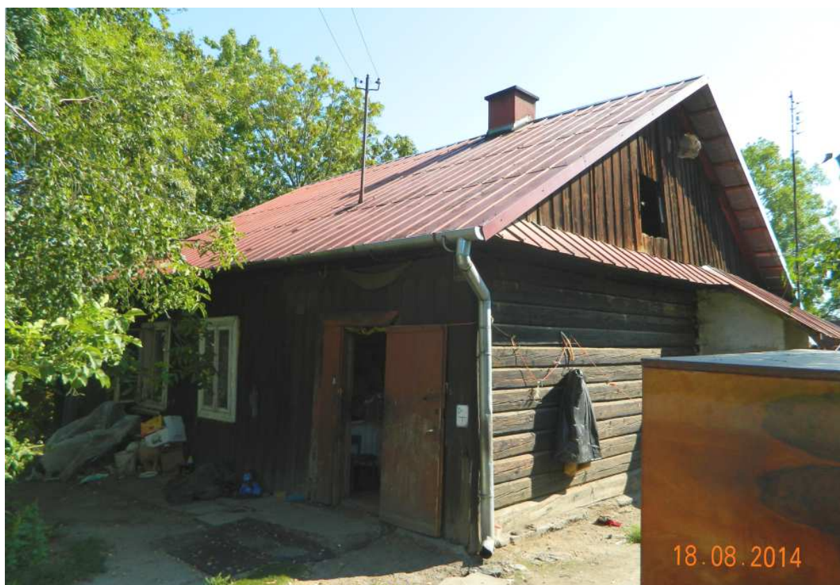
Fot. nr 62 (62-63). Drewniany dom przy ulicy Mickiewicza pod nr 13.
