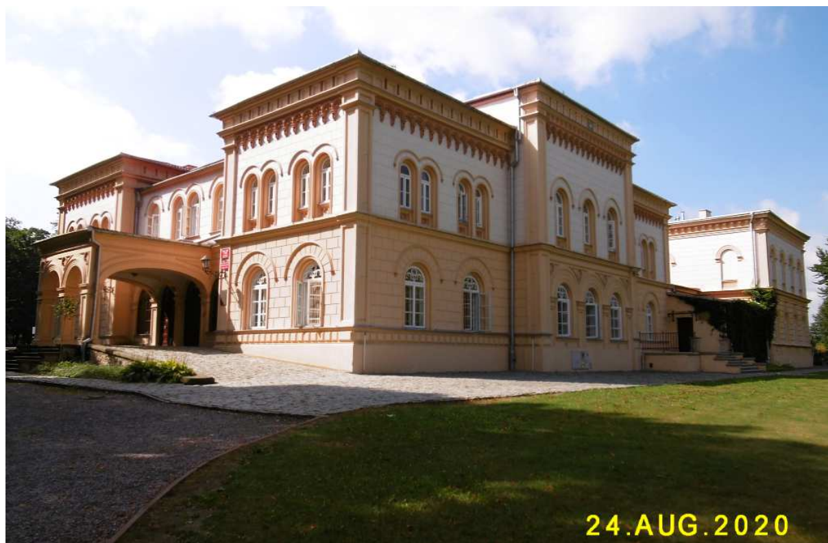
Fot. nr 187 (187-188). Widoki na wschodnią i północną elewację.
