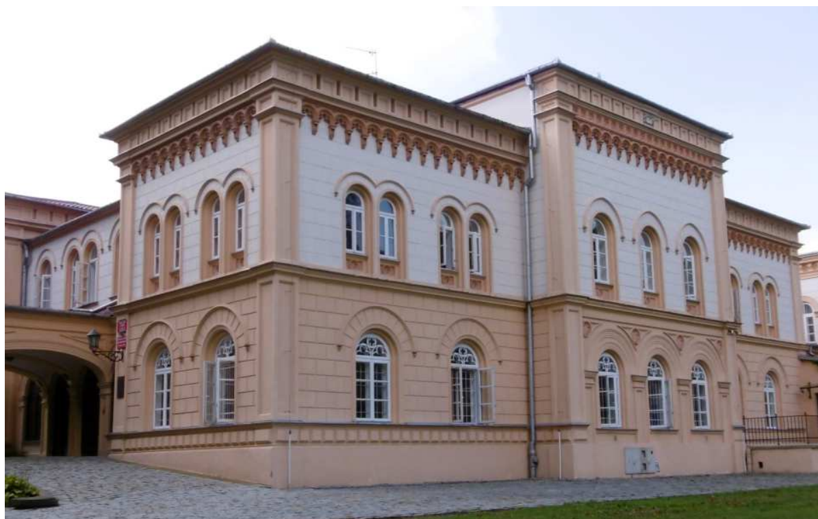
Fot. nr 190 (190-192). Pałac z ryzalitem pośrodku.
