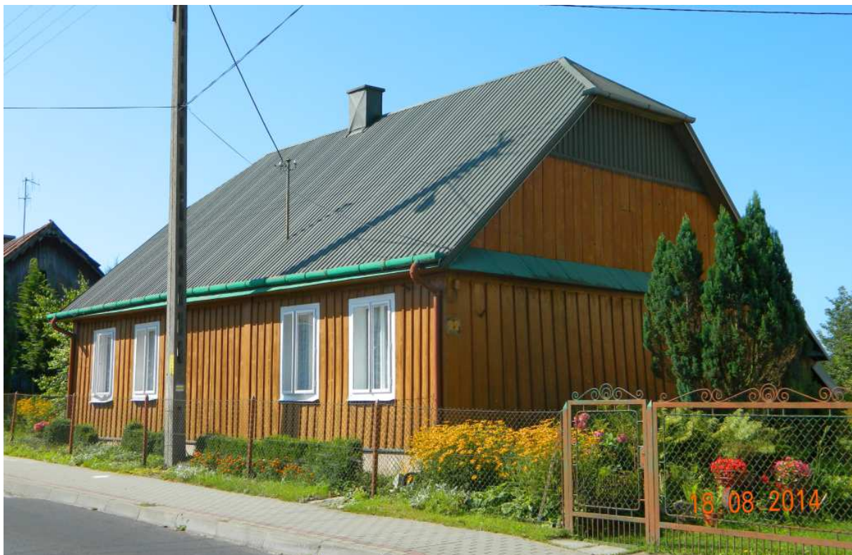
Fot. nr 50. Obity szalunkiem, zapewne około stuletni dom spod nr 22.
