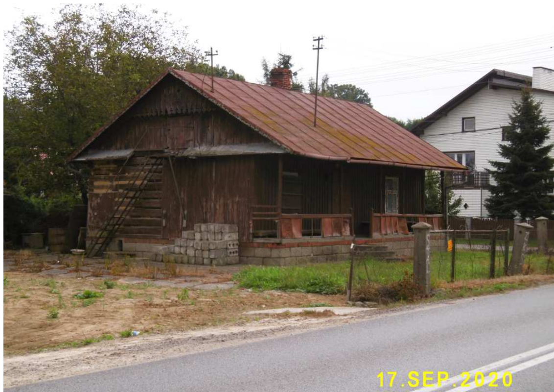
Fot. nr 234 (234-242). Zapewne około 100-letni dom, przypominający karcznię, przy ulicy Budziwojskiej pod nr 363.
