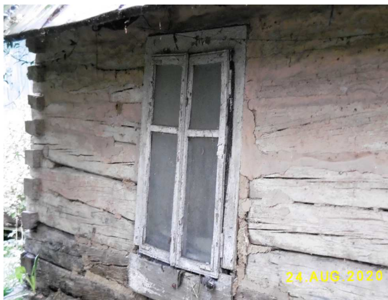
Fot. nr 111. Archaiczne okienko izby mieszkalnej.
