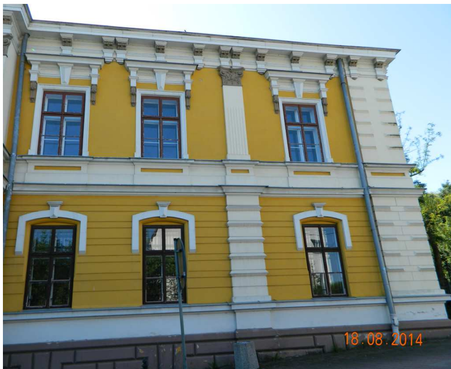
Fot. nr 98. Prawe skrzydło budynku.
