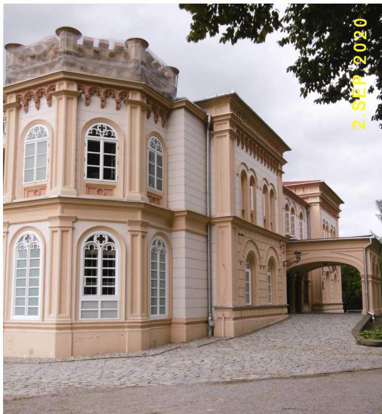
Fot. nr 181 (181-186). Elewacja wschodnia (frontowa) z parterowym portykiem nad wjazdem pośrodku.
