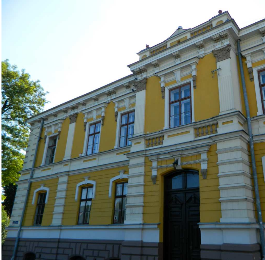
Fot. nr 99. Ryzalit i lewe skrzydło. (18.08.2014)
