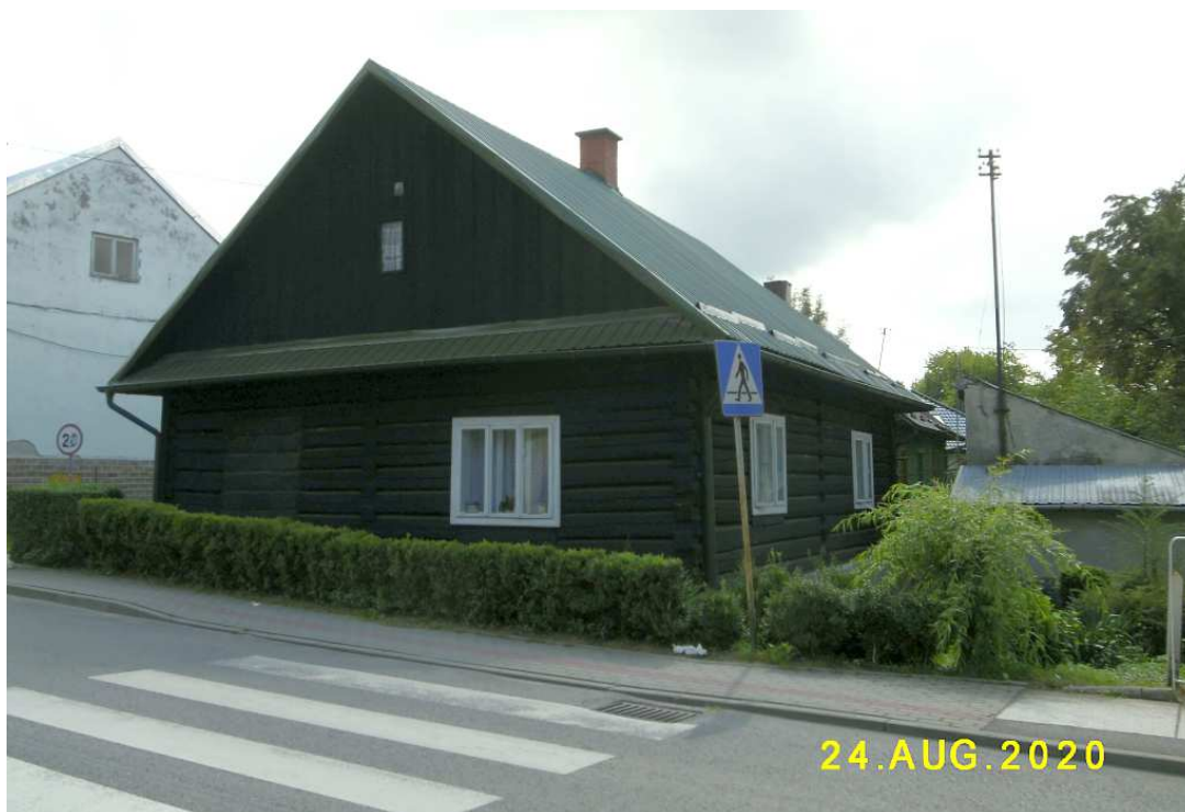
Fot. nr 139 (139-140). Widok na tylną część.
