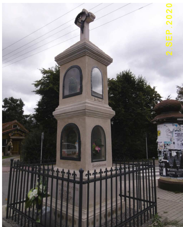
Fot. nr 203 (203-209). Kapliczka słupowa w centrum wsi na etapie renowacji.
