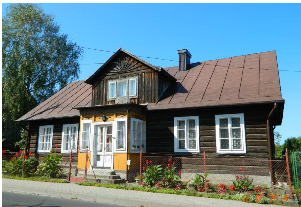
Fot. nr 52 (52-52b). Piękny dom o wyglądzie dworku spod 26. Ten oryginalny, drewniany obiekt o konstrukcji zrębowej, który mógł powstać na przełomie XIX i XX wieku, zachował dawne detale: ościeżnicowe okna, zaskłoly ganek na kształt werandy oraz facjatkę.
