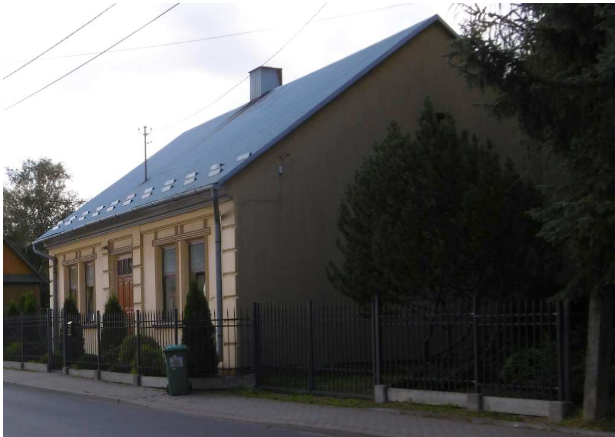
Fot. nr 49. Murowany dom przedwojenny spod nr 20. (24.08.2020)
