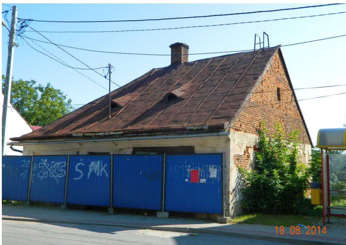
Fot. nr 78 (78-81). Parterowy dom spod nr 1, który przez sześć lat czeka na remont.
