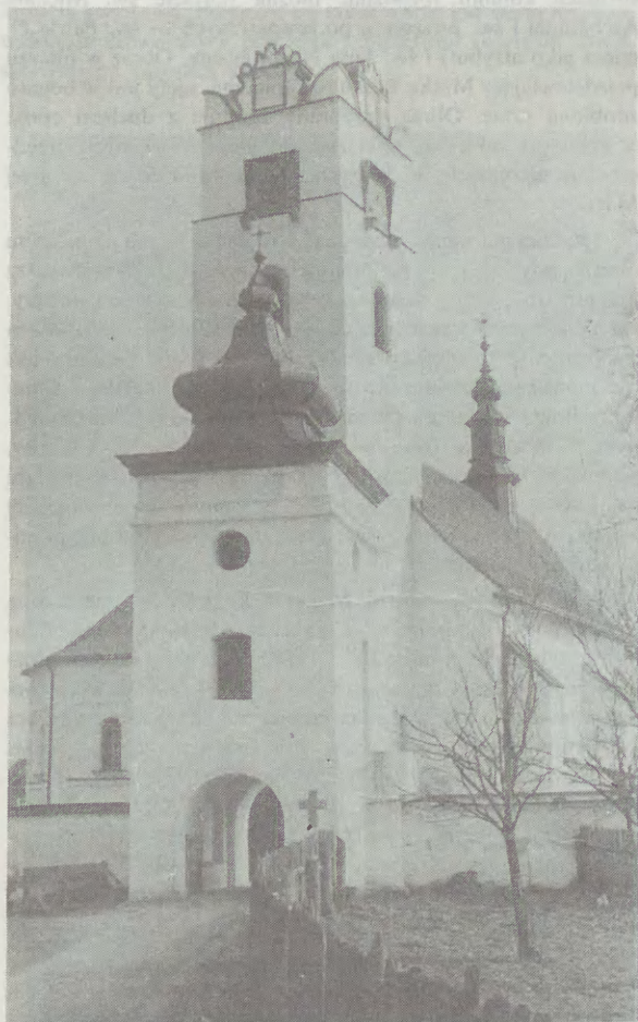
Kościół we Frydmanie. Widok na kościół i dzwonicę od zachodu.
