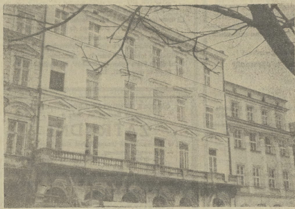
Znikają powoli ruszłowania spod zabytkowej kamienicy przy Rynek Gł. nr 25. Coraz bliżej jest dzień, w którym wprowadzą się tutaj przyszli użytkownicy. Fot. W. KLAG
