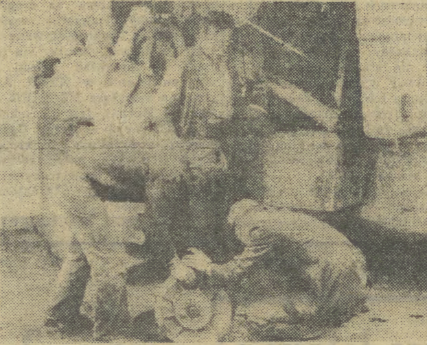
Marzyny muszą być sprawne. Każda awaria szybko zabawia serwis pogotowia technicznego. Na: mechanik awaryjny POM w Lubuszu Eugeniusz Topor wraz z operatorem Marjanem Kulczarem oraz Antonim Kubatem przy naprawie kombajnu „Bizon”. Foto. OTTO LINK
