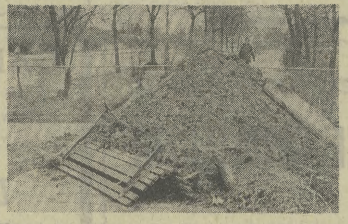
Przy ul. Bulwarowej trwają prace przy instalowaniu przewodów gazowych. A przy okazji niszczy się lawki... Pol. A. Gugała
