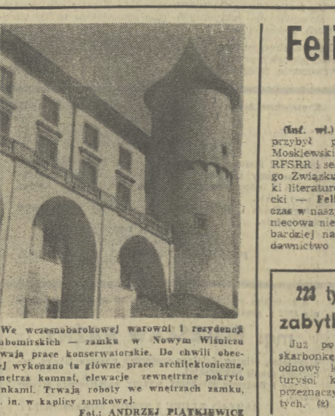
We wczesnobarokowej warowni i rezydencji Lubomirskich — zamku w Nowym Wiśniczu trwają prace konserwatorskie. Do chwili obecnej wykonano tu główne prace architektoniczne, wnętrza komnat, elewacje zewnętrzne pokryto tynkami. Trwają roboty we wnętrzach zamku, m. in. w kaplicy zamkowej. Fot.: ANDRZEJ PIĄTKIEWICZ
