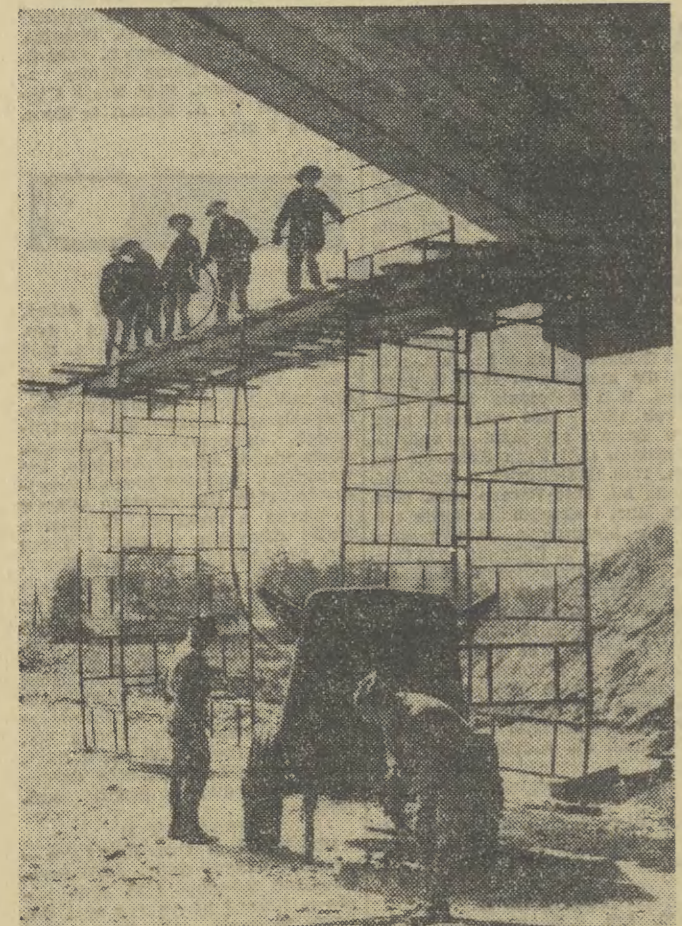
Na trasie szybkiego ruchu Warszawa — Katowice — łączącą stolicę ze Śląskiem — pracują żołnierze LWP. Budują oni m.in. wiadukt w Częstochowie. Na zdjęciu: żołnierze wojsk kolejowych i drogowych z pododdziału dowodzonego przez ppor. inż. Zdzisława Bindera zatrudnieni przy pracach zbrojeniowych.
