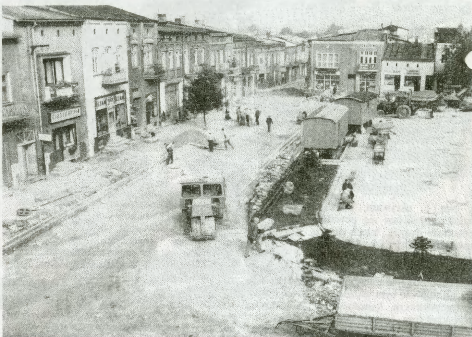
W trakcie remontu.
