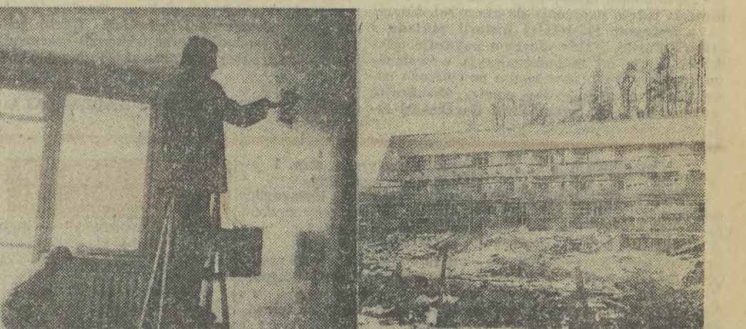
W Limanowej dobiega końca budowa Domu im. Janka Krasickiego. Najbardziej zaawansowane są prace w części hotelowej obiektu, powinny one zostać ukończone Jeszcze w tym roku. Wszystkie roboty wykonują uczniowie Zespołu Szkół Budowlanych z Limanowej. Pozostałe części obiektu w tym sala widowiskowa ukończone zostaną w terminie późniejszym. (f)
