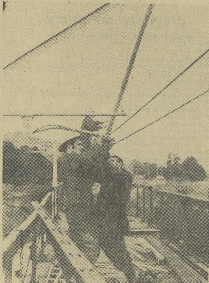
Wiele wysiłku kosztuje monterów PKRE z Warszawy podwieszanie linii elektrycznej. Zdjęcia: OTTO LINK
