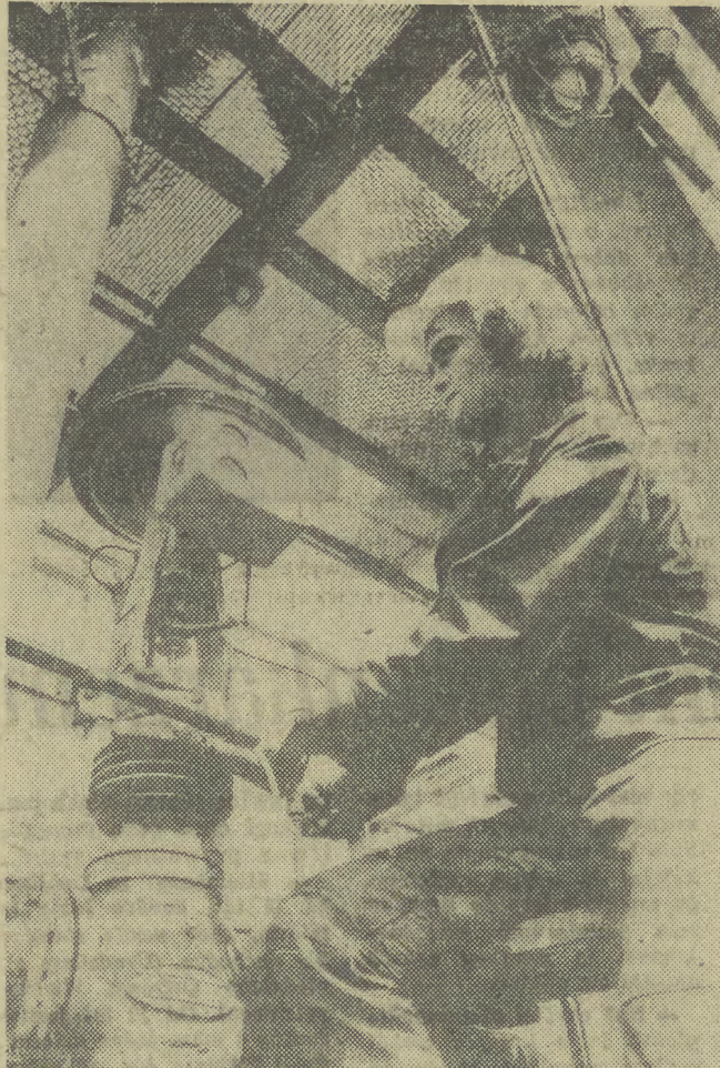
Przy Zakładach Azotowych w Puławach powstaje Wytwórnia Kopolaktamu. Jest to ogromna instalacja, zlokalizowana na wielkim obszarze. Obecnie prowadzone są prace wykończeniowe i wyposażeniowe nowego zakładu. Docelowo produkcja puławskiej wytwórni wynosić będzie 50 tys. ton kopolaktamu rocznie, który przeznaczony będzie głównie na potrzeby gorzowskiego „Stilonu”.
