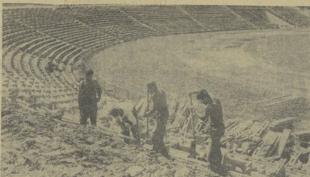
Tradycyjne już w naszym kraju ogólnopolskie święto plonów — dożynki, odbędą się w tym roku w Koszalinie. W związku z tym miasto chce pokazać się licznym gościom z jak najlepszej strony. Trwa przebudowa ciągów komunikacyjnych oraz zakładanie nowych, kolorowych elewacji na wiekszości domów. Przebudowuje się również miejscowy stadion KS „Gwardia”. Na zdjęciu: przebudowa miejscowego stadionu.
