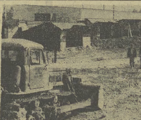
Przy ul. Krzywda w pracach przy budowie nowego placu dla krakowskiej „tanaty”, która przepięść się tutaj ma już w najbliższy piątek.
