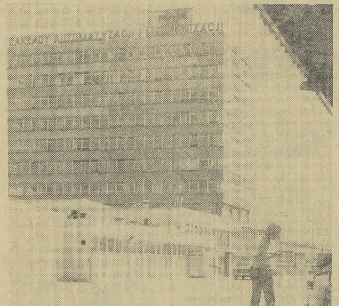
Biurowiec Zakładów Automatykacji i Mechanizacji w Kętach. Fot. ARCHIWUM
