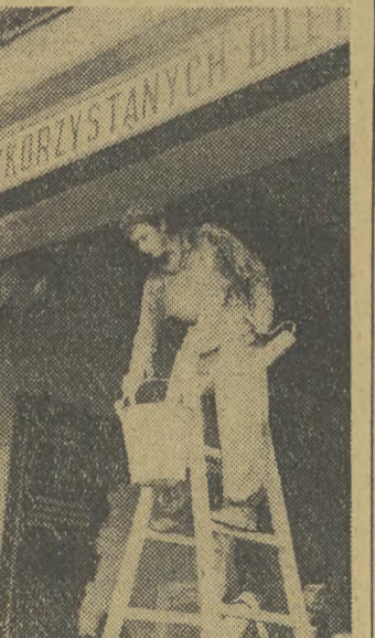
Przy normalnym ruchu pasażerów przystopowało do kosmetyki (czytaj - malowania) pomieszczenie Dworca Głównego PKP w Krakowie...
