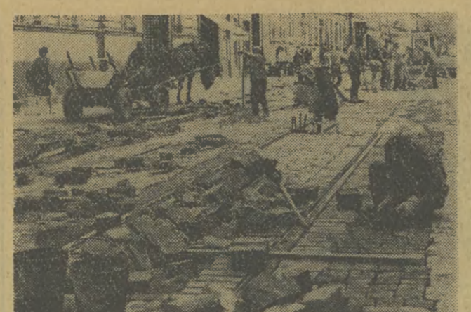
Torowisko w ul. Karmelickiej poddawane jest generalnemu remontowi. Wymienią się szyny tramwajowe i podkłady. Oby na trwałe! Fot. W. Klag
