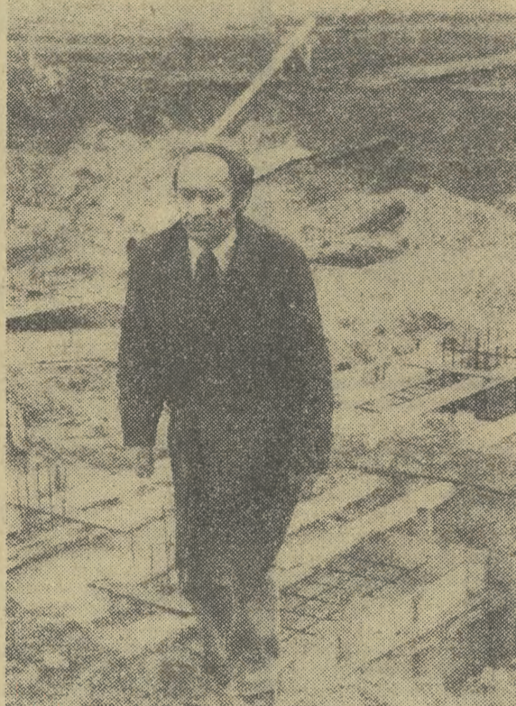
Rektor Staruch: — Wychodzimy już z ziemi... FOT. O. LINK
