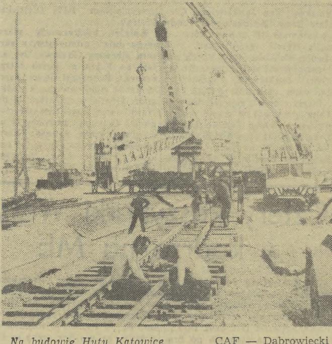
Na budowie Huty Katowice CAF — Dąbrowiecki
