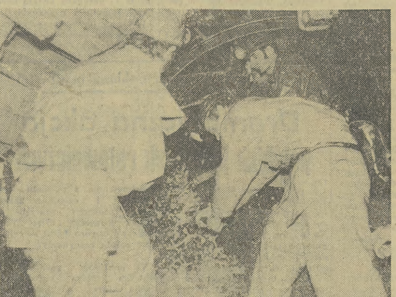
Tak wygląda w praktyce walka ludzi z wodą przy budowie chodnika w „Pomorznany”. Fot. B. OPIOŁA
