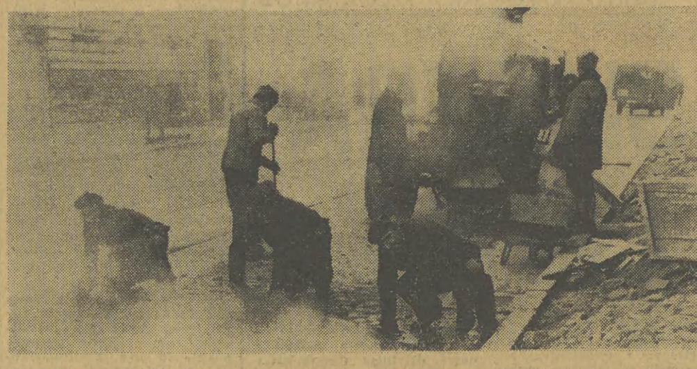
Na ulicy Boh. Stalingradu kładzie się nawierzchnię asfaltową. Fot. Wacław Klag
