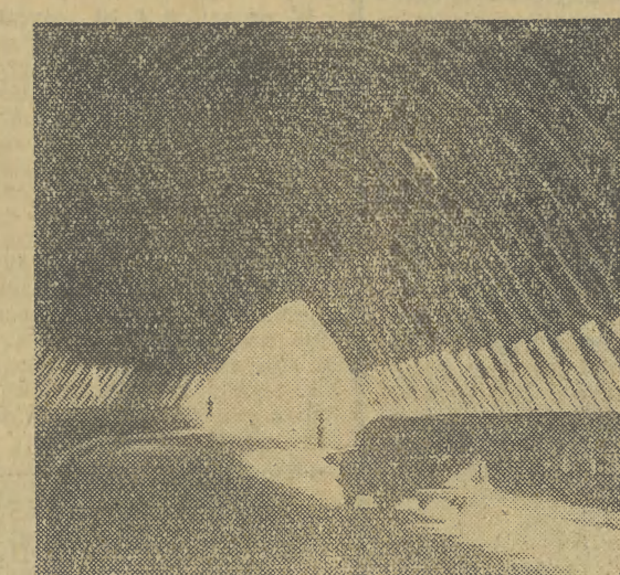
Fragm. autostrady biegnącej przez przełęcz Salang w górach Hindukuszu, zbudowanej przy współpracy afgańsko-radzieckiej. Fot. — CAP
