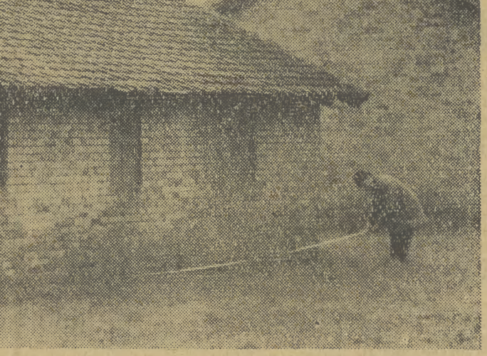
W ramach czynności wizji lokalnej, wykonanych w dniu wczorajszym, m. in. miernicy sądowi dokonali wiele pomiarów mających sformułować fakty podane przez świadków oskarżenia z warunkami na terenie obozu oświęcimskiego.
