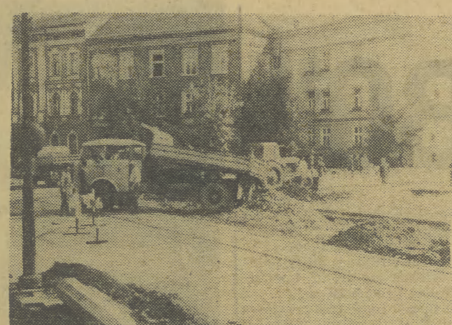
Trwają prace przy naprawie torów oraz poszerzeniu jezdni ul. Zwierzynieckiej (kolo „Jubilata”). Fot. A. Turczański
