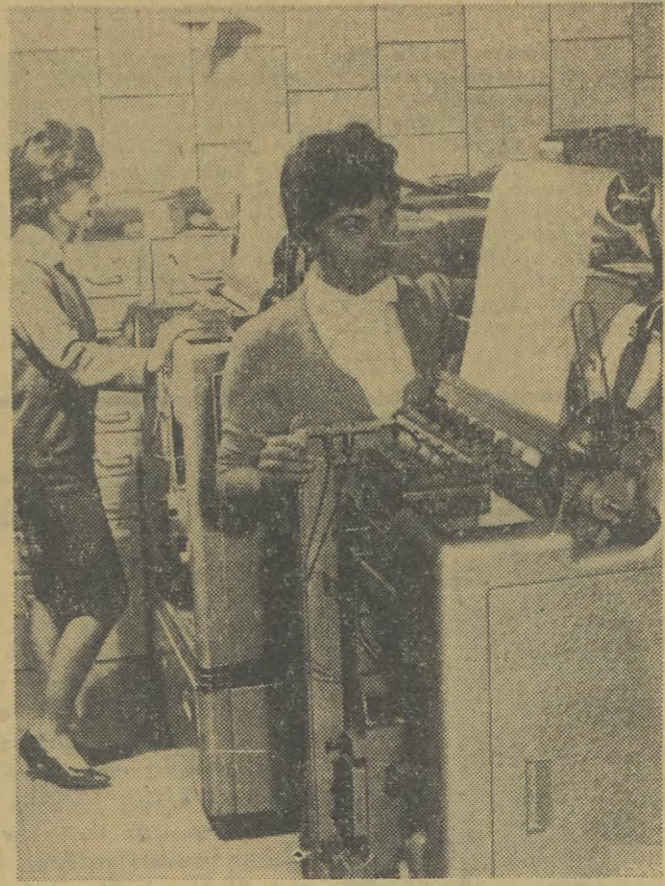
Przemysł lekki przeprowadza próby automatyzacji i mechanizacji szeregu prac administracyjnych, żmudną pracę rachmistrzów zastępuje specjalnymi maszynami analitycznymi. Taka właśnie stacja maszyn analitycznych czynna jest w ZBP im. Marchlewskiego w Łodzi. Przewodzi ona m. in. ewidencje stanów magazynowych w zakładzie, a różnych magazynów jest tu aż 37.
