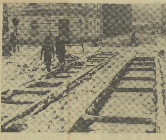
Przy ul. Wawrzynica trwa remont torów. Fot. W. Klag
