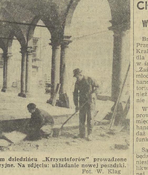
Na zabytkowym dziedzińcu „Krzysztofów” prowadzone są prace renowacyjne. Na zdjęciu: układanie nowej posadzki. Fot. W. Klag
