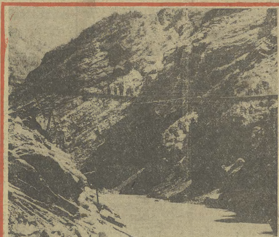
W Tadżykistanie powstaje Roguńska Elektrownia Wodna, której produkcja roczna wyniesie 14 miliardów kilowatogodzin. N/Z: teren budowy. CAF — TASS
