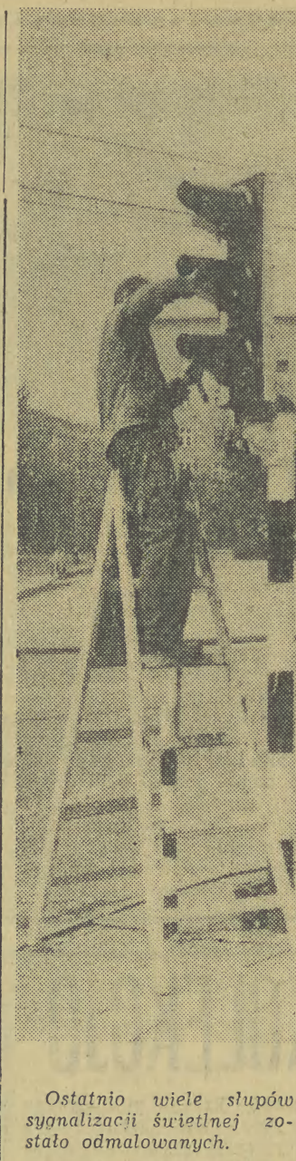
Ostatnio wiele słupów sygnalizacji świetlnej zostało odmalowanych. Fot. W. Kleg
