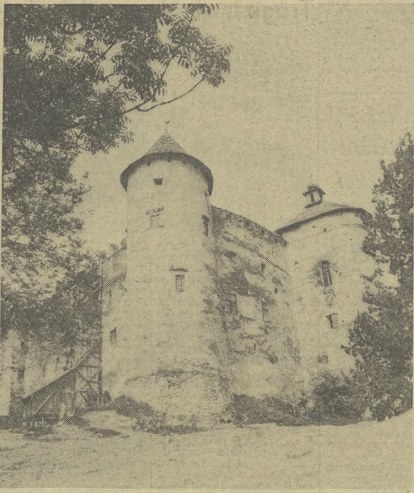
Jednym z najlepiej zachowanych zabytków na Podhalu jest Zamek w Niedzicy. Mimo trwającego obecnie remontu, przybywają tu — zwłaszcza w sezonie turystycznym — liczne wycieczki. FOT. WACŁAW KŁAG
