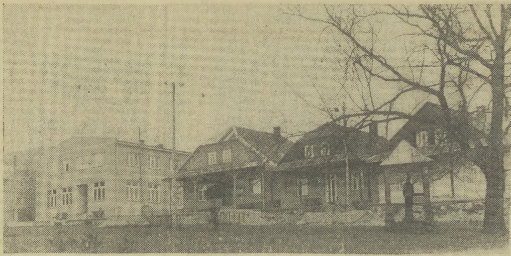
Czehów, rynek. Obok zabytkowych domów wyrósł gmach Prezydium GRN. Otwarcie budynku zaplanowano na 30 kwietnia br.
