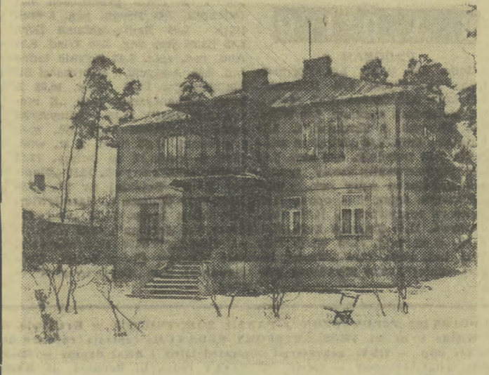
Budynek w Wawrze przy ul. Poprzecznej II, w którym odbył się „sąd” nad mieszkańcami Wawra. CAF — Szyperko
