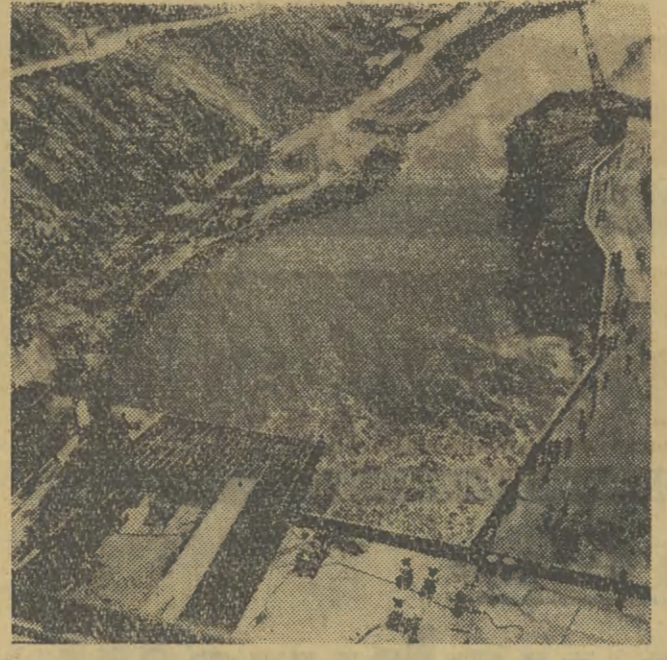
Z pomocą ZSRR budowana jest w miejscowości Naglu w Afganistanie największa w tym kraju hydroelektrownia o mocy 90 tys. kilowatów. Dwa pierwsze agregaty są już podłączone do sieci i zaopatrują w energię miasto Kabul oraz kombinat tekstylny w Gulbarkharze. Rozruch wszystkich pozostałych urządzeń elektrycznych w Naglu nastąpi przed końcem III kwartału przyszłego roku. Na zdjęciu: widok na zapórę wodną i rzekę Kabul przy nowo hydroelektrowni w Afganistanie. CAF — TASS
