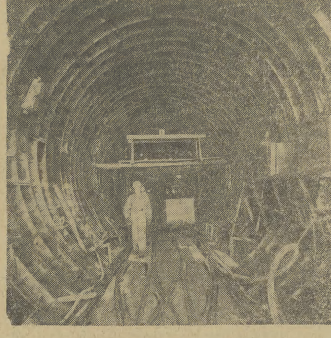
Budowa tunelu w pobliżu stacji Cesko-Budojevičské Namesti,
