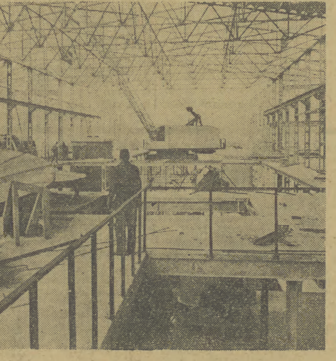
BUDOWA NOWEJ CUKROWNI W WERBKOWICACH (POW. HRUBIESZÓW)
