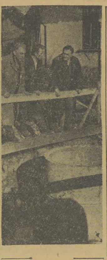
Od dwóch lat ta studnia czeka na zakończenie budowy. Służyć ma ona zaopatrzeniu w wodę całego zakładu Babszórskiej Drzewnej Spółdzielni Pracy w Suchej. Jak długo jeszcze trzeba będzie czekać? — na to pytanie może odpowiedzieć wykonawca Krakowskiego Przedsiębiorstwa Budownictwa Ogólnego. Fot. — O. Link
