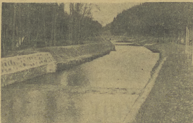
Obecnie Rycerski Potok ujęzdmiony regulacją płynie już nowym korytem. Fot. Otto Llnk
