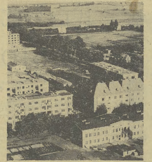
Gnieźnieńskie osiedle Tysiąclecia w budowie.
