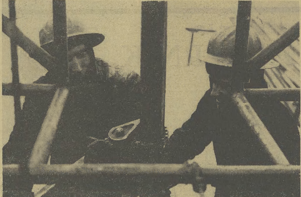
Wiercenia badawcze w osi głównej zapory. Tym urządzeniem wierci się otwór kierunkowy. Pracami kieruje wiertacz Jurusik. CAF — Piotrowski
