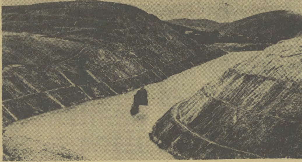
W południowych Chinach ukończona została budowa Kanału Młodzień przy ujściu rzeki Lei-czou. Kanał ciągnie się poprzez górzyzny teren na przestrzeni 30 kilometrów. CAF
